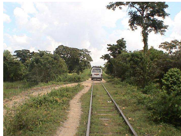
Foto No. 5) Invasión Vehicular del Derecho de Vía.
