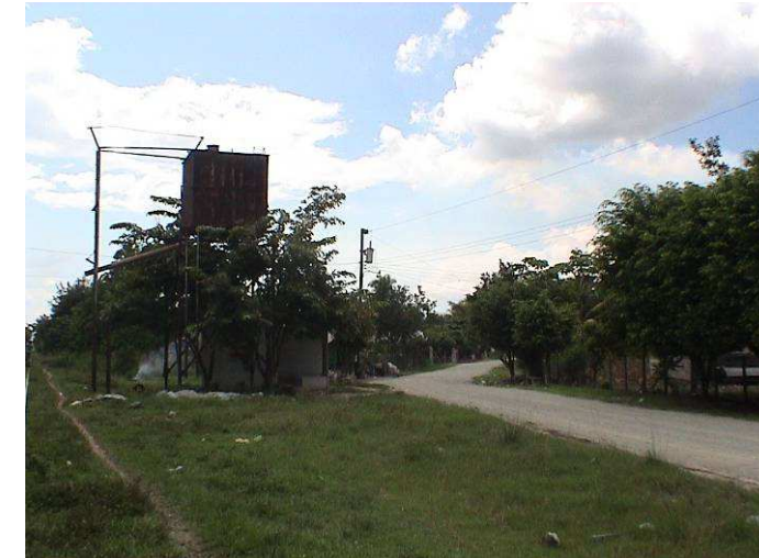
Foto No. 6) Deposito de Agua, York.
