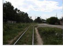
VISTA DE ESTACION DE YORK
