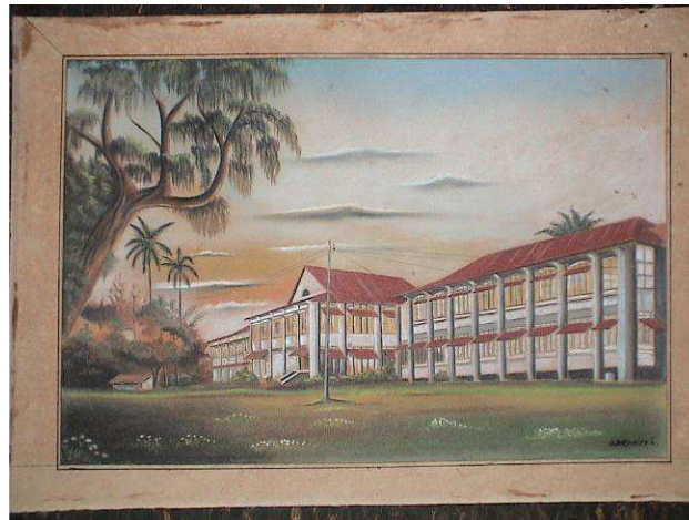
Foto No. 19 Antiguo Hospital de Quiriguá, Fuente: Sr. Brooks. Septiembre 2004
