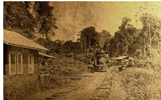
Foto No. 2) Estación de Tenedores
