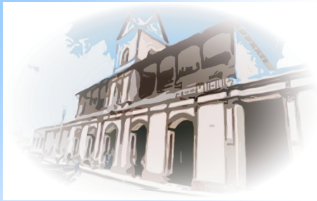
Fotografía No. 15 Edificio que alberga las oficinas de la municipalidad de San Pedro Sacatepéquez, San Marcos.
