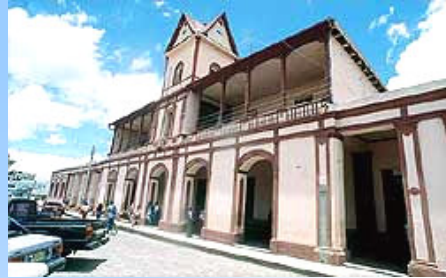
Forografía No. 1 Fachada del Palacio Municipal
