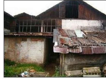
Fotografía No. 10 Esta vista muestra que el techo es viejo y oxidado, se observa el avanzado deterioro y sugiere actuar inmediatamente.
