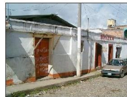
Fotografía No. 11 Otro ejemplo de las construcciones vernaculas del municipio. Las fachadas de las viviendas son planas y por ser de adobe se observan las ventanas de poca dimensión. Como la municipalidad no cuenta con un reglamento de conservación específica para su patrimonio sucesos estos casos de estereotipo.
