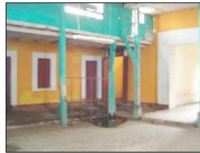
Fotografía No. 04 Este es el ingreso que toma el salón Jardín Samporano, esto también es el acceso a las gradas que van al segundo nivel, se vuelve a presentar el estomero de los paneles de madera y también se evidencia las goteras de agua ya que el techo es viejo y oxidado.
