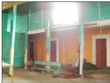
Fotografía No. 03 Aquí se observa el estomero que presentan los pilares de madera que sostienen lo que queda del techo del antiguo salón Jardín Samporano.
