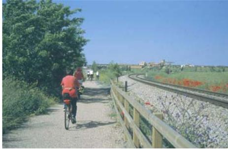
Foto No. 3 Uso de barreras para evitar un contacto directo con el ferrocarril.
