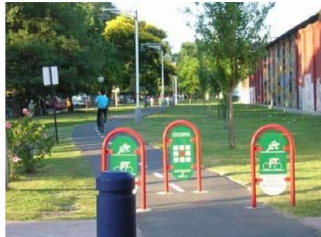
Foto No.5. Bolardos para evitar el paso de Vehículos motorizados.
