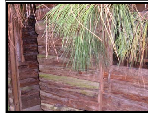
Forro exterior con madera
