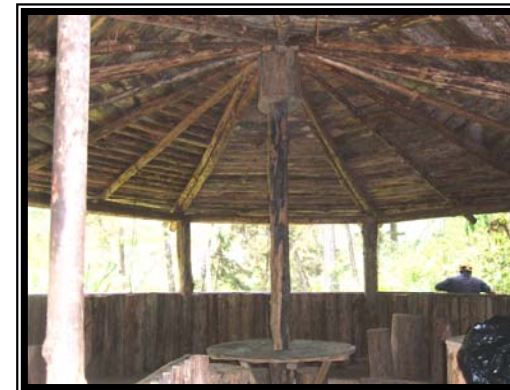
Estructura con madera rolliza
