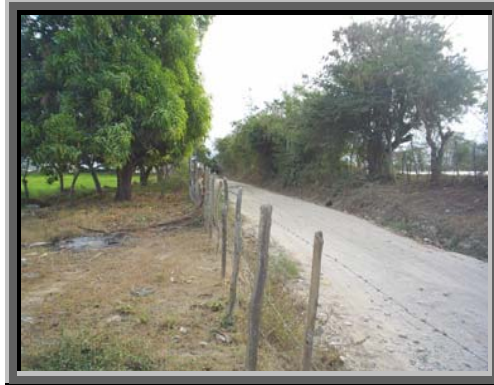
Fotografía No. 18 VISTA CALLE PRINCIPAL calle proveniente del casco urbano, terracería en buen estado conduce hacia la aldea El Guayabal
