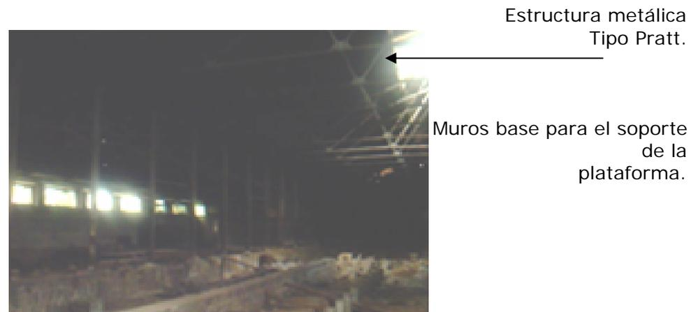
fotografía No.47 Estructura Metálica y plataformas de piedra.
