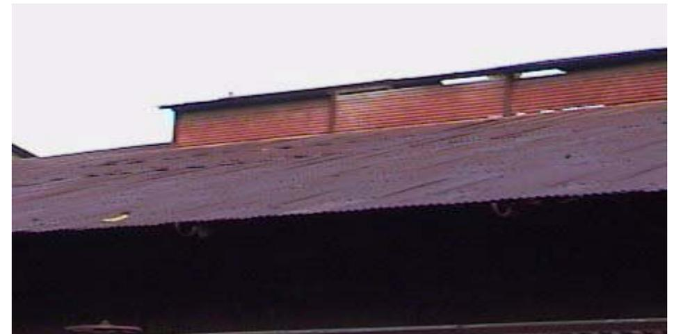
Fotografía No. 61. Se observa el deterioro causado por el soleamiento y la lluvia. (19/10/03) Elaboración propia.
