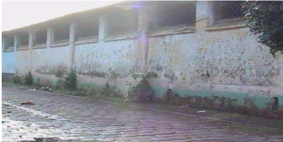
Fotografía No. 60. Se observa el deterioro de los muros, causados por la humedad de las lluvias. (19/10/03) Elaboración propia.
