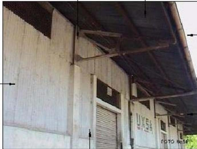
Las cubiertas son de lámina de zinc sobre estructura de acero, se presionan los perfiles L y T accionados en el momento de la instalación ya que cuentan con un grado de corrosión.
