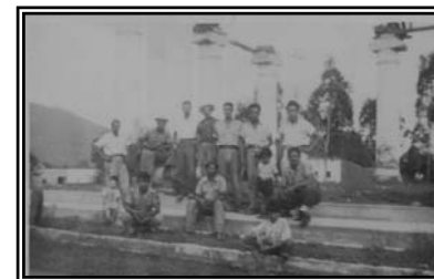
Trabajadores Sección de Caminos. Reconstrucción Templo de Minerva 1,955. Foto No. 1. Colección privada Prof. Osberto Reyes.
