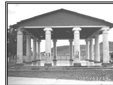
Fachada Frontal Oeste Templo de Minerva Foto No. 42
