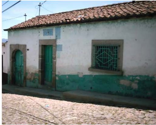
Fotografía No. 5.12 Fachada tradicional con elementos neoclásicos Fuente: investigación propia.
