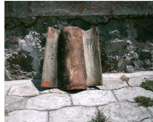
Fotografía No. 6.29 Teja de barro de 0.30 x 0.15 x 0.02 utilizada en el techo de las construcciones tradicionales, del corredor urbano. Fuente: investigación propia
