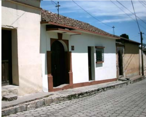
Fotografía No. 7.1 Fachada conservada y tratada de manera correcta. Fuente: investigación propia.
