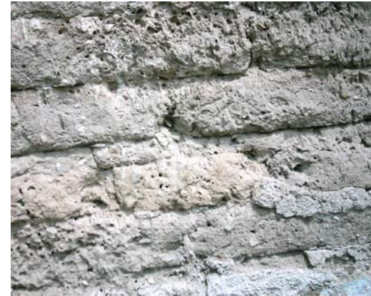
Fotografía No. 6.28 Muro de adobe, de 0.40 x 0.40 x 0.12, en construcción tradicional, del corredor urbano. Fuente: investigación propia.
