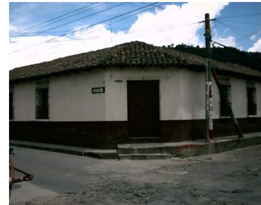
Fotografía No. 5.10 Vivienda típica dentro del Barrio Histórico La Transfiguración Fuente: investigación propia.
