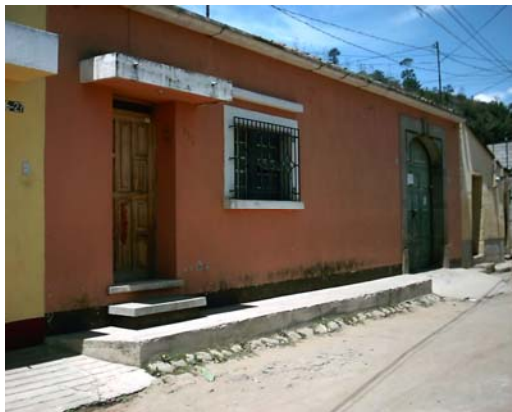
Fotografía No. 7.2 Fachada conservada y tratada de manera correcta. Fuente: investigación propia.
