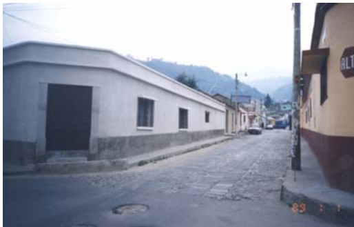
Fotografía No. 6.16 Vivienda larga y de poca altura que da la sensación de aplastamiento. Fuente: investigación propia.
