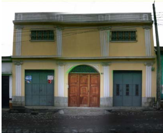
Fotografía No. 6.31 Construcción actual con materiales actuales. Fuente: investigación propia.
