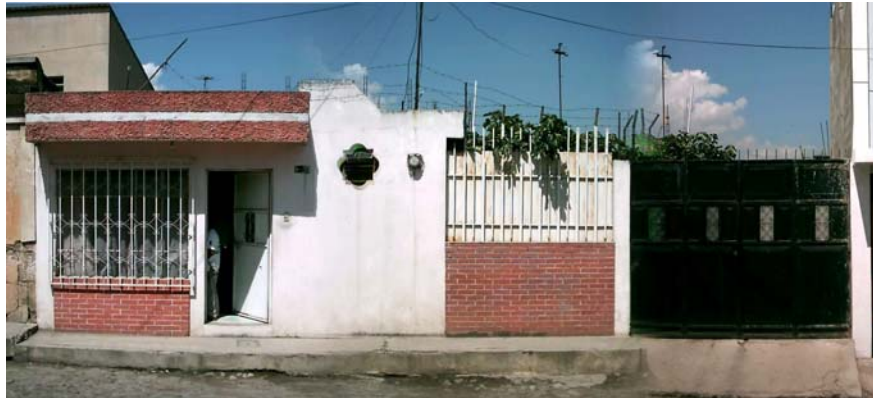
Fotografía No. 6.4 Fachada construida de block, fachaleta y losa de concreto armado plano. Fuente: investigación propia
