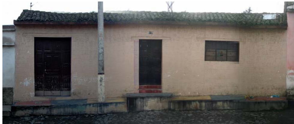
Fotografía No. 5.11 Fachada de corte sencillo con alero, no simétrica Fuente: investigación propia.
