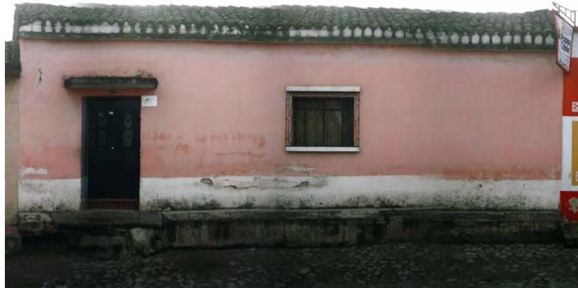
Fotografía No. 6.1 Fachada asimétrica y combinación de vanos con macizos. Fuente: investigación propia.
