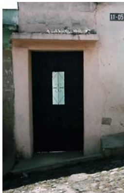
Fotografía No. 6.8 Puerta de metal Fuente: investigación propia
