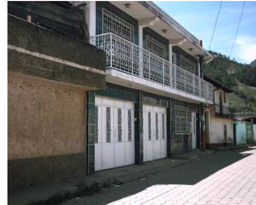
Fotografía no. 5.31 Vivienda que ha perdido los elementos constructivos tradicionales del Barrio Histórico La Transfiguración. Fuente: investigación propia.
