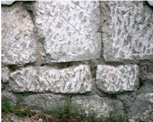
Fotografía No. 6.27 Muro de piedra de tamaño irregular en construcción tradicional. Fuente: investigación propia.
