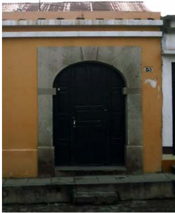
Fotografía No. 6.10 Ingreso a la vivienda, señalada por un arco de piedra rústica llamada jamba y va directo a un pasillo.
