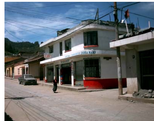
Fotografía no. 5.32 Construcción de dos niveles, la planta baja utilizada como comercio, y la planta alta como vivienda familiar. Fuente: investigación propia.
