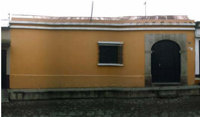
Fotografía No. 6.26 Vivienda tradicional del corredor urbano, del Barrio Histórico La Transfiguración, con el techo cubierto de lámina de zinc. Fuente: investigación propia.
