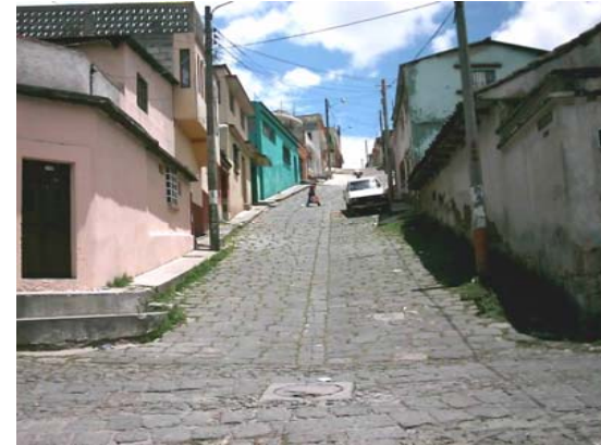
Fotografía No. 5.7 Calles empedradas con dos fajas para el tránsito de automóviles. Fuente: investigación propia.
