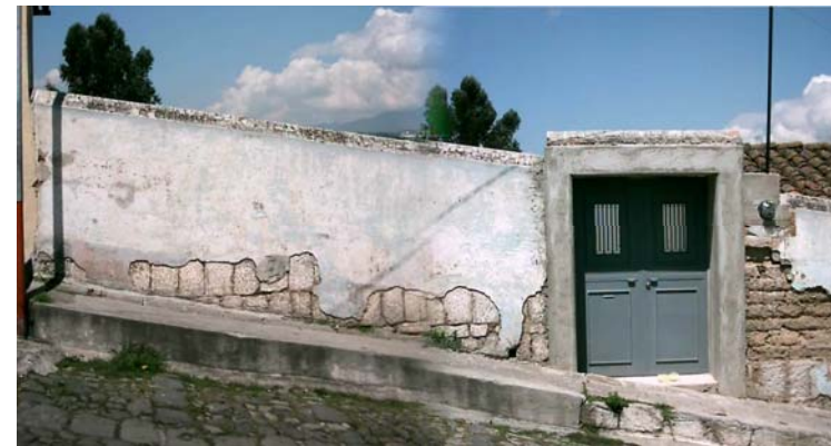
Fotografía No. 6.3 Fachada, construida con material de adobe, piedra y cubierta de teja. Fuente: investigación propia.
