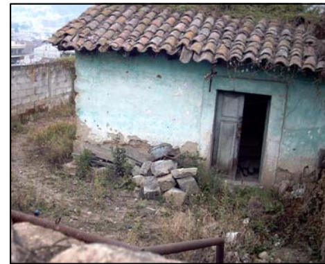
FOTOGRAFÍA DE VIVIENDA UBICADA EN EL CENTRO DEL LOTE
