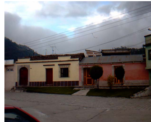
Fotografía No. 5.19 Techo de teja de barro y de lámina galvaniza, uno a la par del otro. Fuente: investigación propia
