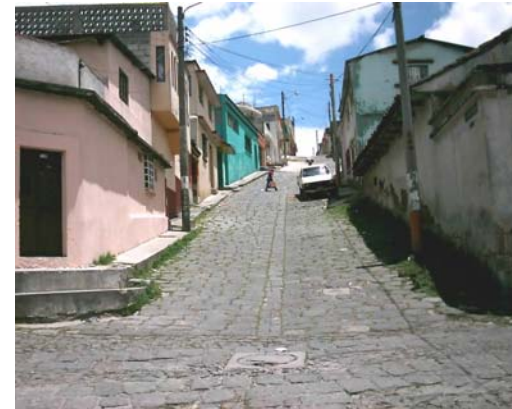
Fotografía No. 5.24 Se observa una vivienda intervenida contrastando con una que esta casi en abandono. Fuente: investigación propia.
