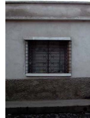
Fotografía No. 6.6 Ventana de hierro angular + vidrio y sobre ventana. Fuente: investigación propia.
