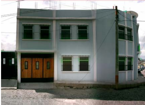
Fotografía No. 6.30 Construcción actual con materiales actuales. Fuente: investigación propia.
