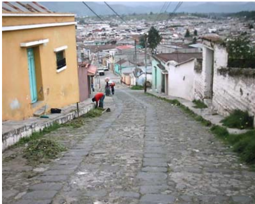
Fotografía No. 5.1 Vista del corredor urbano, desde el Templo Fuente: investigación propia
