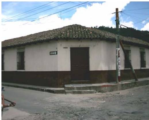
Fotografía No. 5.18 Vivienda típica con techo de teja de barro Fuente: investigación propia
