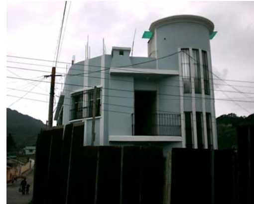
Fotografía No. 5.21 Vivienda en construcción que rompe con las construcciones tradicionales del Barrio Histórico La Transfiguración Fuente: investigación propia
