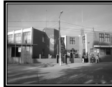
Fachada lateral Foto No. 18
