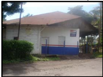
Foto 140. Edificio de correos, presta a la Aldea un servicio, de transportar cartas, telegramas, encomiendas, al servicio de la comunidad, presenta una arquitectura propia de la región, de madera y con cumbrea forrada de madera, techo de lámina.
