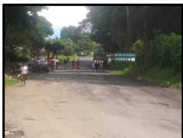
Foto 141. Carretera de terracería que comunica a la CA-2 a 500 mts. de la estación de Palo Gordo, esta carretera también comunica a Tahuexco frontera con México.
