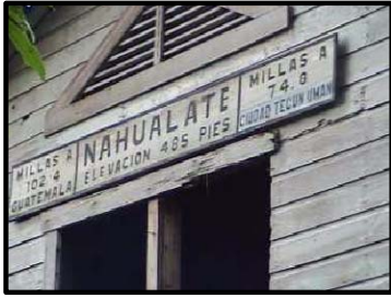
Foto - 90. Rótulo de identificación, dañado por la polilla y hongos en la madera.
