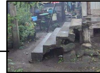
Foto 120 Las gradas del acceso al andén de abordaje, se encuentran muy dañados, sufriendo rajaduras en las partes laterales y una de sus contra-huellas, provocadas por factores climáticos y personas que viven en el sector. Provocando deterioro en las gradas.
