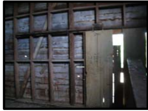
Foto 99. Portón interno de la estación presenta daños como fisuras, en algunas partes les hace falta piezas.
