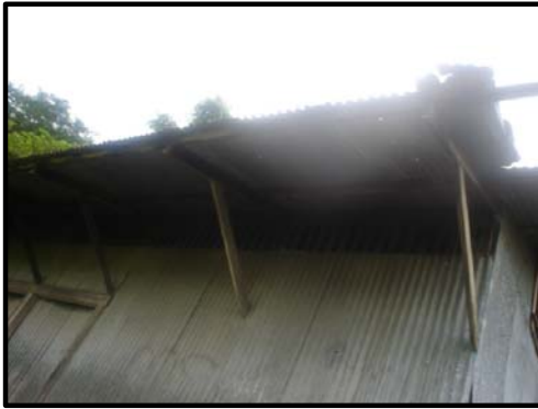
Foto 158 El detalle de las breizas del voladizo se encuentran en un regular estado, ya que la madera se encuentra dañada por agentes biológicos.
