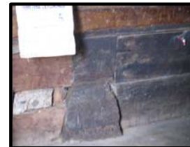
Foto 103. Pilotes de 0.40 x 0.40 de concreto en regular estado.
