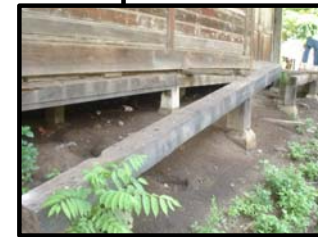
Foto 130 La falta de cuidado en las instalaciones de la estación, personas ajenas al cuidado del patrimonio ferroviario, levantaron los durmientes del andén de abordaje provocando alteración y deterioro del inmueble.
