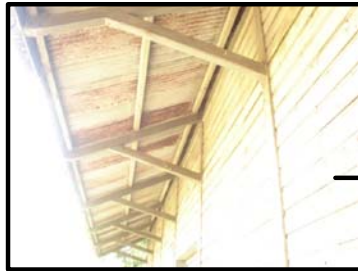
Foto 118 Se puede observar desde el andén de abordaje, las breizas del boladizo se encuentran en buen estado, conservando su detalle original.
