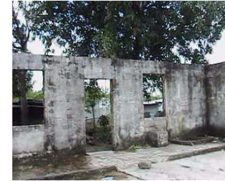
Foto No. 2 Desmantelamiento de las estaciones.
