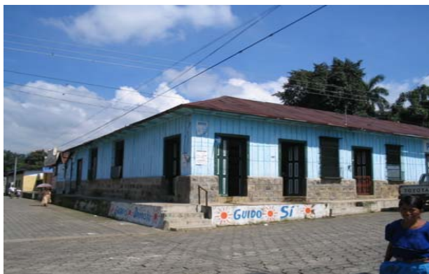
Foto No. 21 Imagen de la vivienda típica de zócalo de piedra y muro de madera. Se localiza al norte del parque central de Chicacao.
