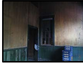
Foto 100. Ventana de taquilla presenta daños en los dinteles de la puerta, y en la ventana le falta algunos vidrios.
