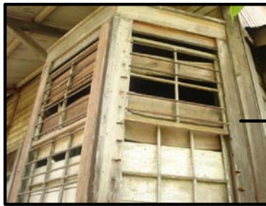
Foto 105. Ventana exterior se encuentra en deterioro, ya que la madera está en avanzado estado de deterioro provocado por termitas y la humedad. Cuenta con balcones de hierro redondo de alma llena en buen estado, ya no existen los vidrios de la ventana tapados por madera alterando el detalle de la ventana original. exterior.
