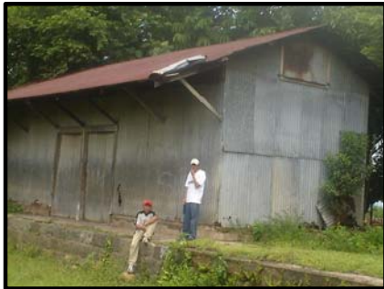
Foto 161 En esta elevación se pueden observar los daños ocasionados por el ambiente natural; la madera de los dinteles de la puerta se encuentran apolillados, la lámina presenta daños en la cubierta por el alto grado de oxidación y corrosión.
