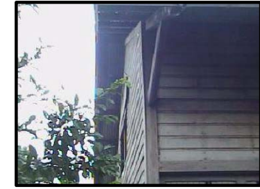
Foto - 92. Brezas de voladizo en un regular estado, presentando daños en la pintura.
