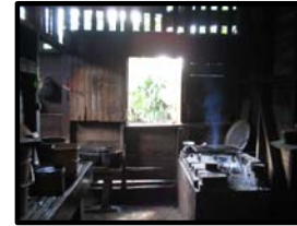
Foto 100. Ventana de taquilla presenta daños en los dinteles de la puerta, y en la ventana le falta algunos vidrios.
