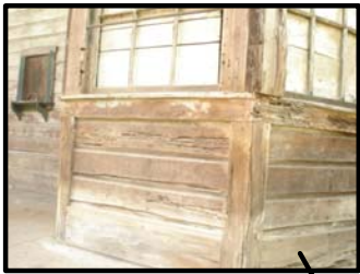
Foto 106. Ventana exterior se encuentra en deterioro, ya que la madera del sillar presenta daños provocados por la polilla y la humedad de la lluvia.
