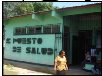
Foto - 81 (I-12) El Puesto de Salud se encuentra localizado en la parte Oeste del edificio en mención. El puesto de Salud cuenta con una enfermera auxiliar y una de las finalidades es el control del desarrollo del niño, campañas de vacunación, charla de prevención de actividades, el área de cobertura es: La Aldea Nahualate, hacienda Moca, finca el Salvador, San Juan Moca, San Pedro Cutzán, Brisas de Moca, Finca Palofox, Finca San Jorge y Santa Catarina Moca.
