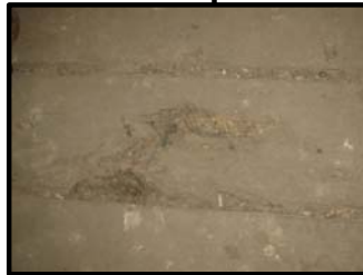
Foto 116 Piso de duelas de madera de la Bodega, se encuentra con rajaduras provocado por la polilla y la humedad.
