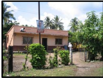
Foto - 76 (I-7) Vivienda típica que se ubica en la parte Oeste de la estación, muros de blocks, losa de concreto, construcciones recientes.
