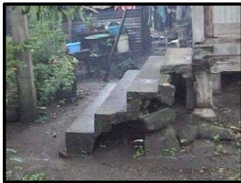
Foto - 91. Gradas del ingreso al andén principal dañados por agentes climáticos y personas antisociales
