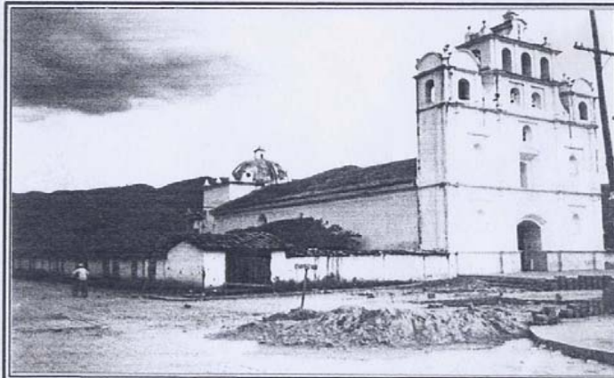
FOTO N° 13 TEMPLO CATÓLICO, LA CAPILLA POSA DEL EXTREMO NORTE Y EL MURO PERIMETRAL.
