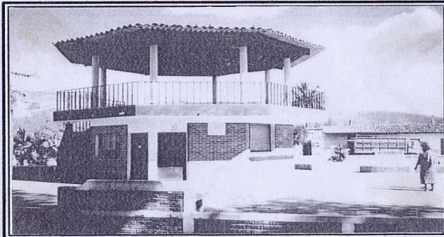
FOTO N° 4 EL QUIOSKO CONSTRUIDO EN 1988.
