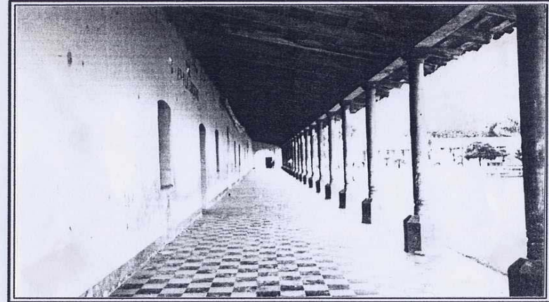
FOTO N° 9 DETALLE INTERIOR DEL PORTAL
