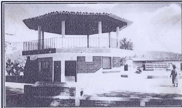
FOTO N° 4 EL QUIOSKO CONSTRUIDO EN 1988.
