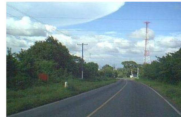
Fotografía No. 28 Ruta Nacional 14 (NA-14) de Antigua Guatemala al departamento de Escuintla, a su paso se encuentra con poblados, tales como: Alotenango, San Pedro la Huertas y Ciudad Vieja.
