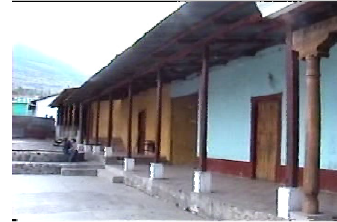
Corredor (h) en edificio de escuela del ala norte - sur (antiguas aulas).
