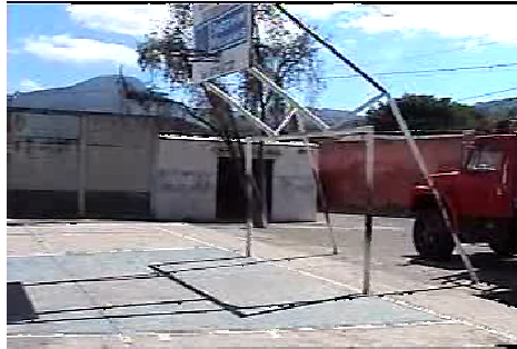
Vista Sur-Este de la cancha, alrededor de ésta área se estacionan vehículos tanto de tipo livianos como pesados.
