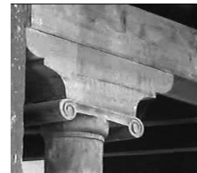
Fotografía No. 87 Detalle de zapatas en columnas del corredor del edificio del ala este-oeste del conjunto escolar Matías de Paz.
