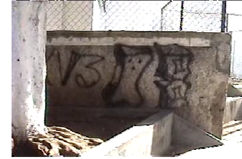
Debido a la utilización de árboles con raíces superficiales, las bancas sufren de fisuras y agrietamiento.
