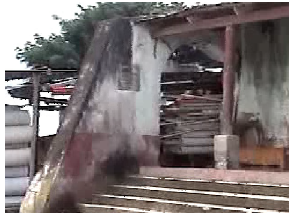
Contrafuerte ubicado a un costado del arco del corredor (d) y de gradecrío (e).
