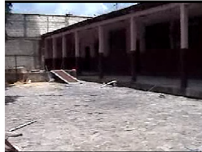
Área de recreo No. 3 en edificio del ala este - oeste.
