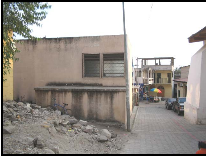
1.6.3.16 FACHADA LATERAL IZQUIERDA MUNICIPALIDAD
