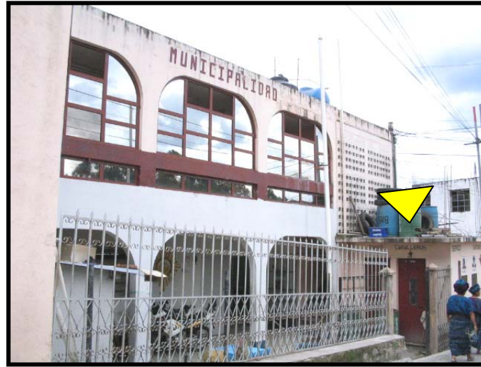
1.6.3.17 FACHADA FRONTAL MUNICIPALIDAD
