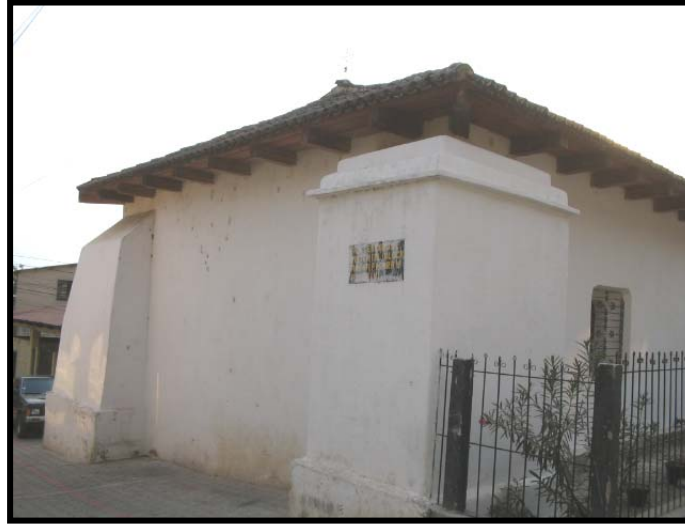
1.6.3.14 FACHADA POSTERIOR IGLESIA
