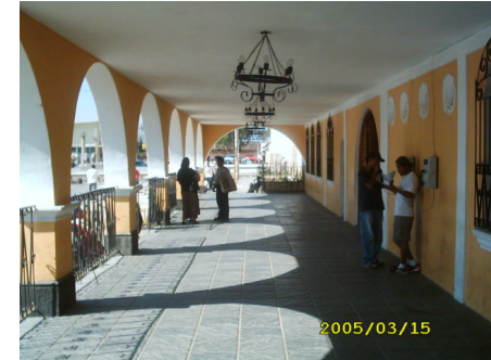
Foto No. 1 Detalle del Corredor
