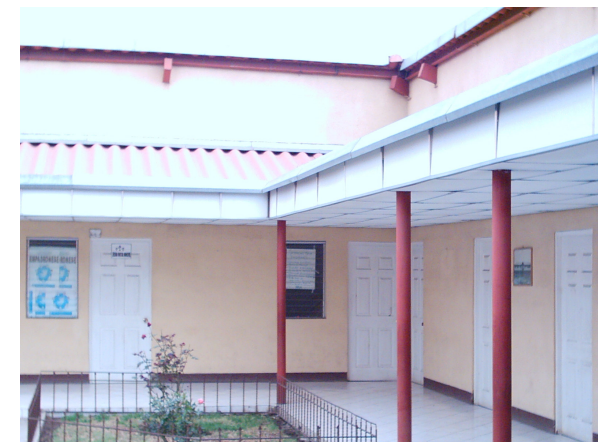
Foto No. 2 Detalle Corredor Municipalidad
