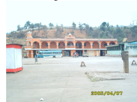
Foto No. 1 Detalle de la Fachada Principal
