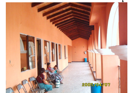
Foto No. 2 Detalle Corredor Municipalidad
