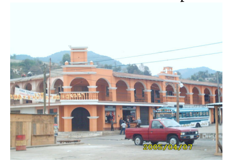
Foto No. 3 Detalle Fachada Municipalidad
