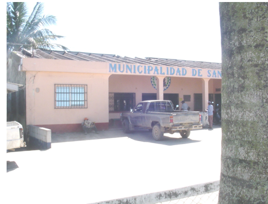
Foto No.5 Vista frontal del edificio Aquí también se observa la falta de espacio para parqueo.
