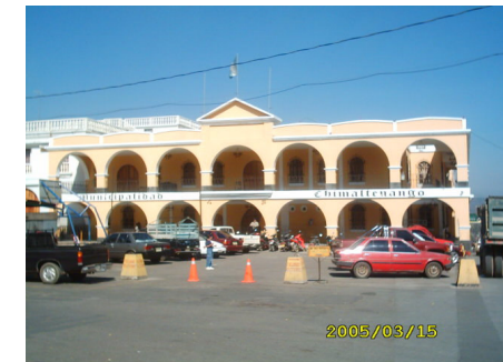
Foto No. 2 Fachada Principal del Edificio
