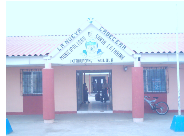
Foto No. 1 Detalle de la Fachada Principal
