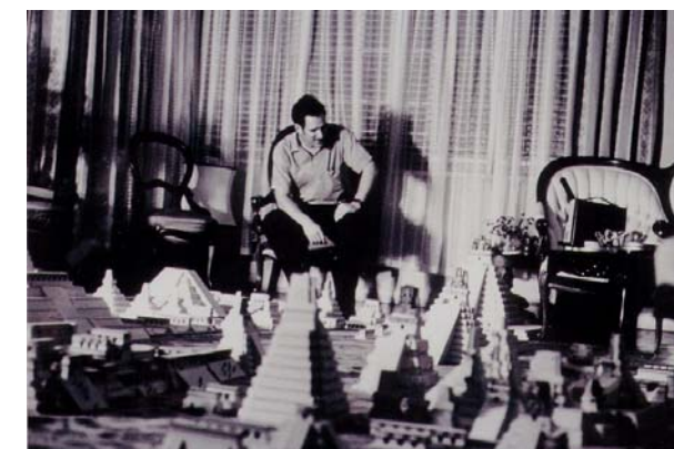
FIGURA 5.120 Proceso constructivo del modelo de Tikal en la década de lo 60 (Alfredo Mackeney)
