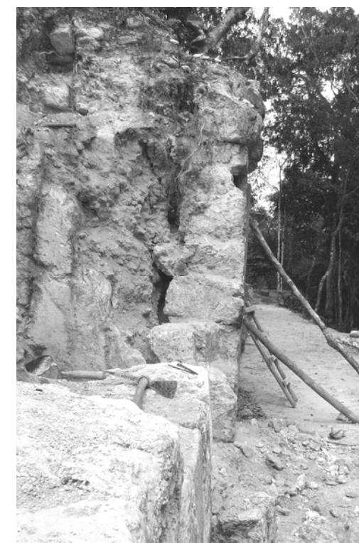
Fig. 22. Muro apuntalado, se aprecia la piedra caliza canteada que forra todo el núcleo central Edificio D Nakum. (Luis Guardado)
