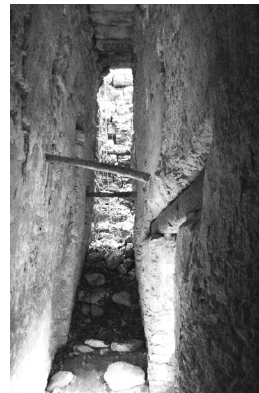
Fig. 41. Interior de la bóveda de Chochkitan, se aprecian pasadores y su dintel original Peten 2,004. ( Oscar Quintana)
