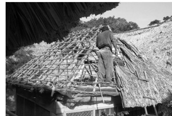
Fig. 48. Trabajos de mantenimiento en una cubierta de Guano, Nakum Peten. ( B.R.G.M.)
