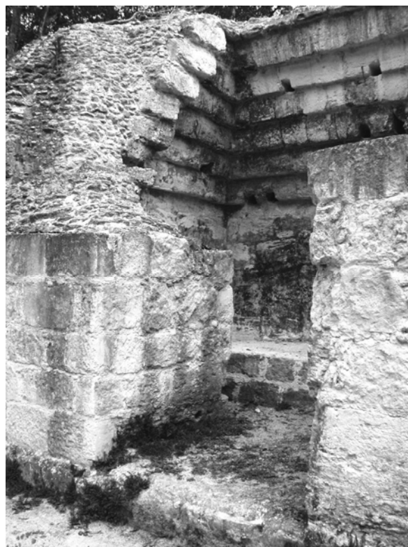
Fig. 37. Bóveda Escalonada Edificio R, Nakum Peten. (Luis Guardado)
