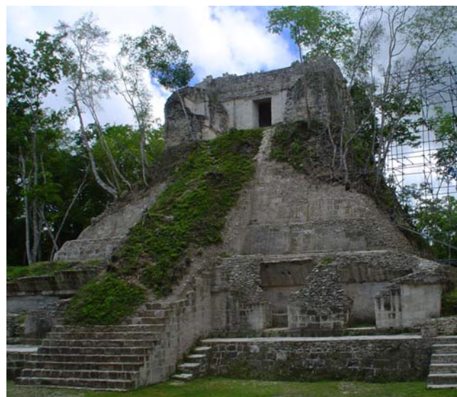
FIGURA 5.116 estado actual del edificio E de Nakum (Noriega 2005)
