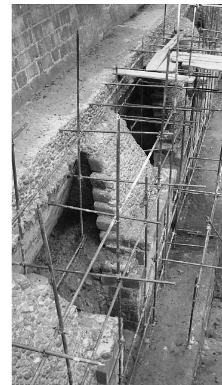
Fig. 50. Detalle de los trabajos de Restauración en la bóveda de aproximación en el edificio Z de Nakum Peten. (Luis Guardado)
