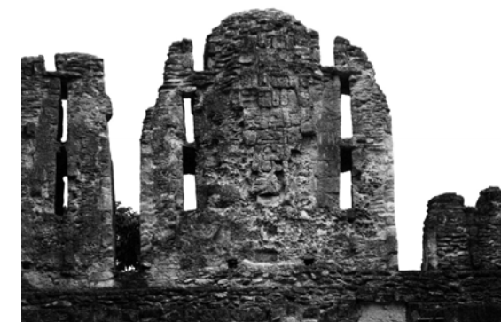
Fig. 45. Crestería de tres torres con pasadores de aire, Edificio A, Nakum Peten. (Luis Guardado)
