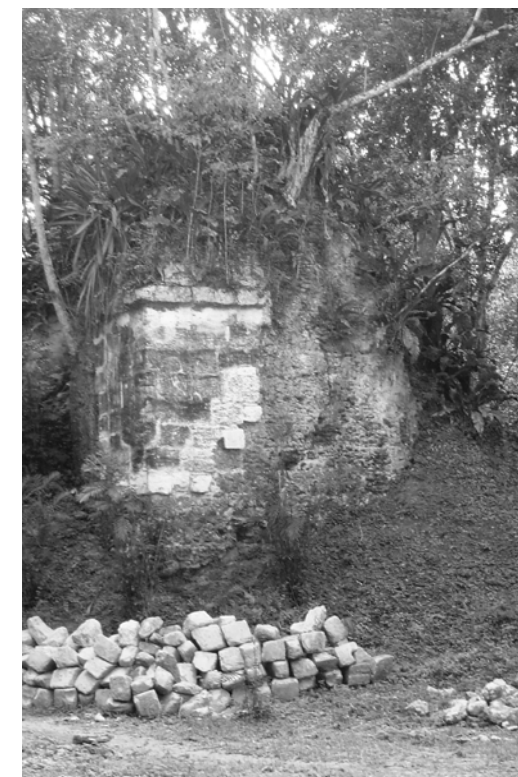
Fig. 53. Edificio P, vista núcleo central del muro con piedra fachaleta, cornisa, dobelas de bóveda en el suelo. Nakum (Luis Guardado)
