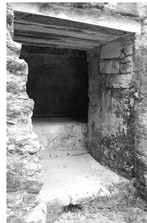
Fig. 28. Acceso a la cámara del edificio N, dinteles restaurados con jambas.
