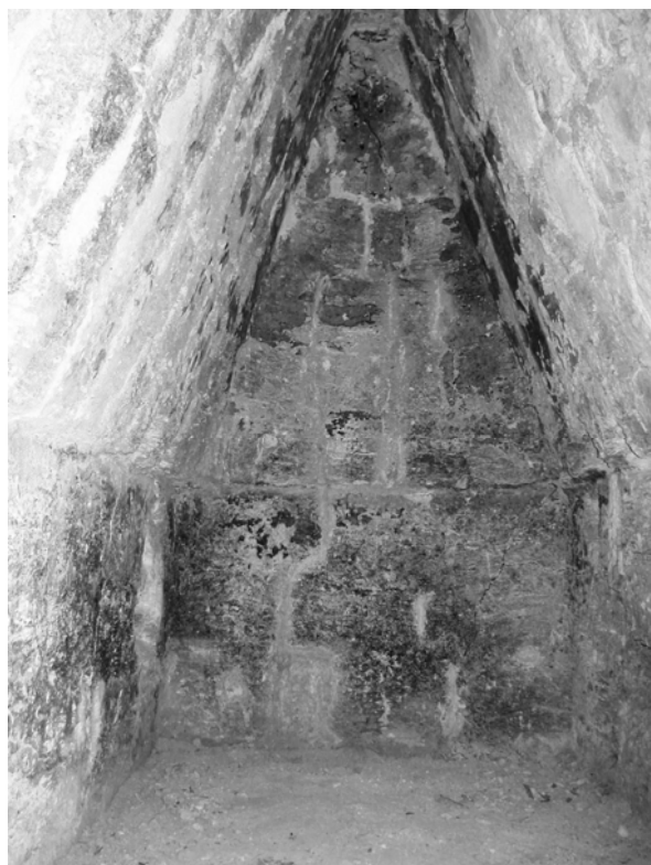
Fig. 36. Bóveda de la cámara inferior Edificio N, Nakum Peten. (Luis Guardado)
