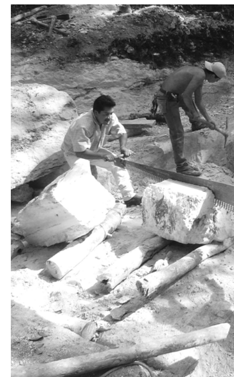
Fig. 05. Corte de una piedra caliza recién extraída de la roca madre, cantera Nakum 2,004. (Luis Guardado).
