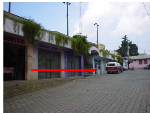
FOTO 2. Aquí se encuentra la oficina de obras municipales, que se localiza en un local comercial afuera del edificio municipal.
