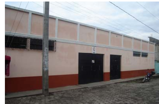
FOTO 10. Esta es la fachada norte del edificio municipal.
