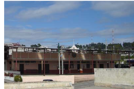
FOTO 9. En esta fotografía se aprecia la fachada principal del edificio que actualmente ocupa la municipalidad de Sumpango.
