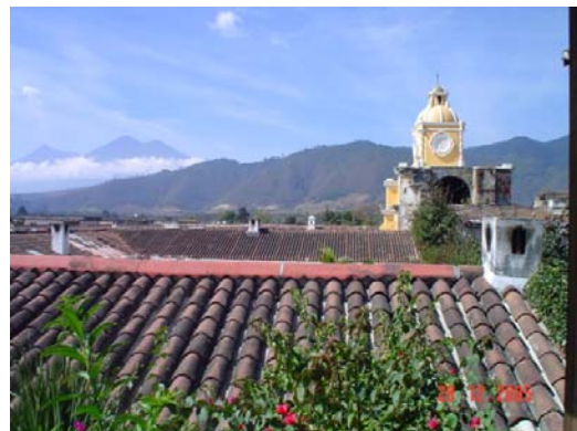
LEVANTAMIENTO FOTOGRAFICO. Monumentos de arquitectura domestica. Ciudad de Antigua Guatemala. 2006
