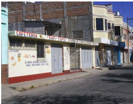
Fotografía No. 28 Clínica medica especializada, localizada en el casco urbano, enfrente del hospital departamental de la Cabecera de Jutiapa
