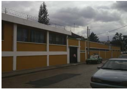
Fotografía No.5 Fachada principal Hospital de Ortopedia y Rehabilitación Dr. Jorge Von Ahn ubicado en zona 1 capitalina
