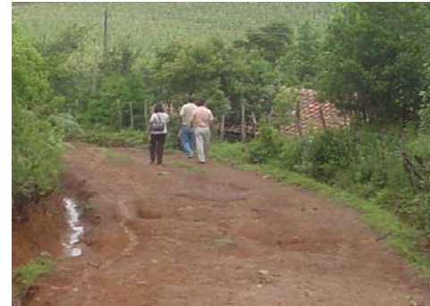
Fotografía No.43 Camino aledaño a el terreno el conduce de la carretera principal hacia el caserío La Labor
