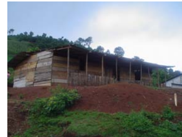
Fotografía No.24 Vivienda en la comunidad de Los Anonos construida de materiales como madera y cubierta de lámina
