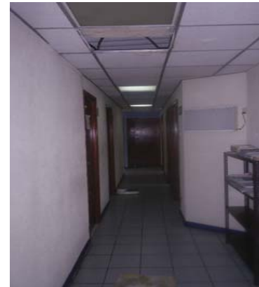
Pasillo Principal en Clínica AGAR
