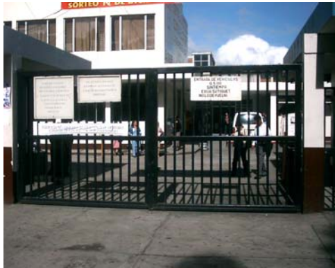
Fotografía No. 47 Ingreso principal a hospital
