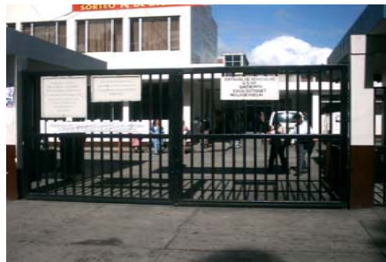
Fotografía No. .1 Ingreso principal hospital de Cancerología
