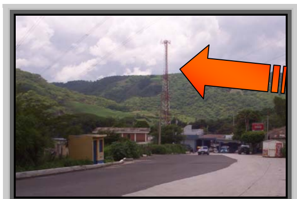
FOTOGRAFÍA No.26. Se ve la antena de telecomunicaciones en la Frontera de Valle Nuevo.
