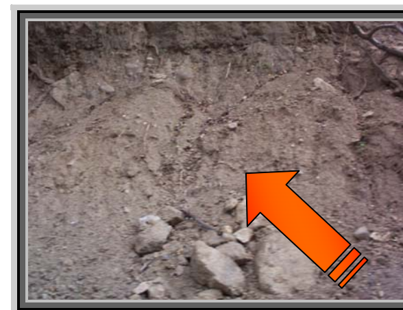
FOTOGRAFÍA No.11. Se puede observar como se ha erosionado el suelo.
