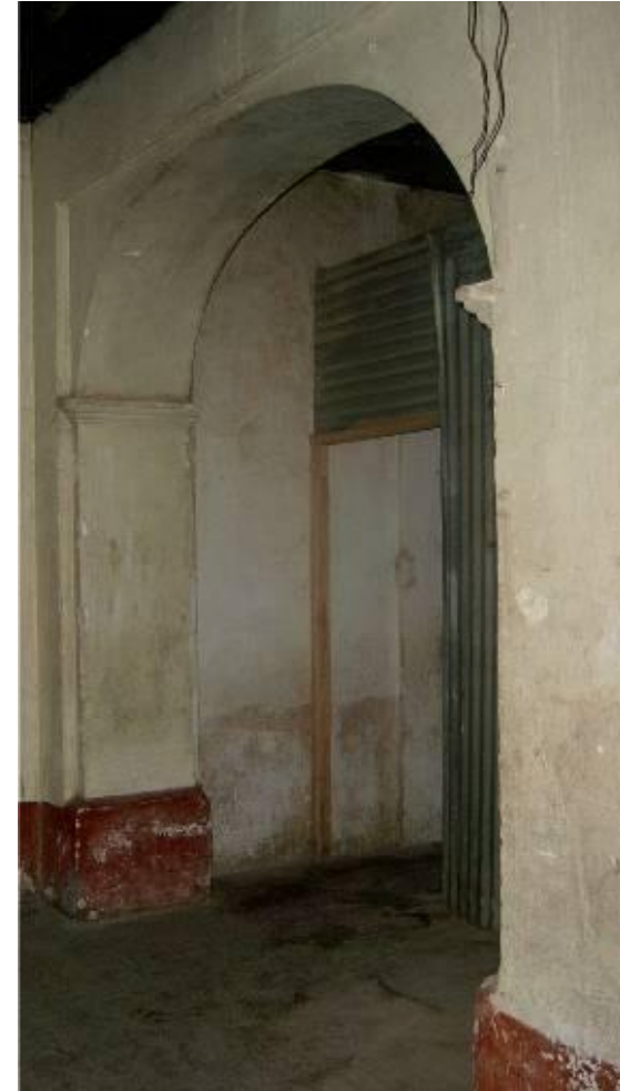
Foto XIII: Se observa el arco del zaguán de ingreso, detalle arquitectónico importante dentro del conjunto
