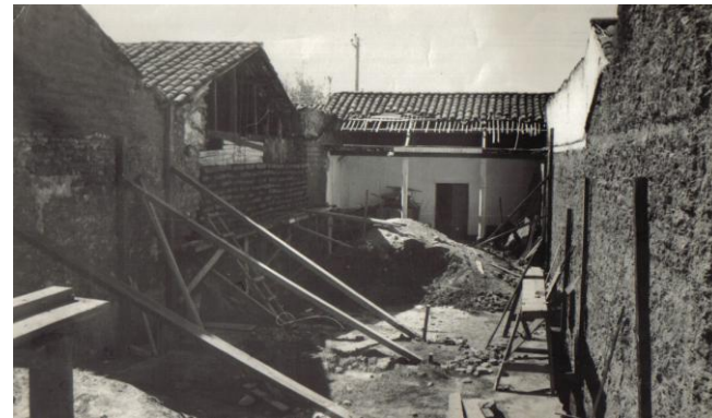
A2, Vista de los trabajos de construcción del Salón de Usos Múltiples en el año de 1978.
