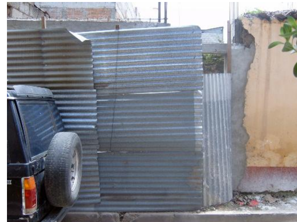
FOTO 10. Vivienda que actualmente esta en construcción, en su interior se puede observar que se han modificado sus características arquitectónicas.
