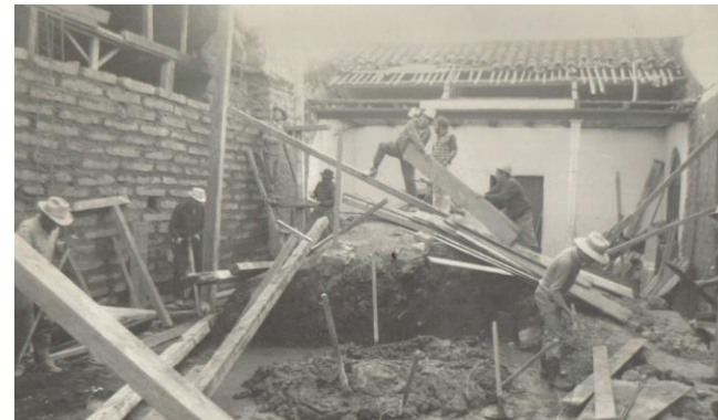
A3, Vista de los trabajos de construcción del Salón de Usos Múltiples en el año de 1978.
