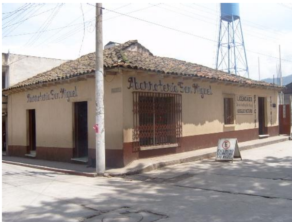
Foto 15 , falta de uniformidad en los elementos que conforman la fachada, mantiene el techo de teja y las paredes son de adobe.
