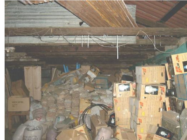
Foto XXIV: Uso del espacio para bodega de la municipalidad y carpintería, se observa el abandono total.
