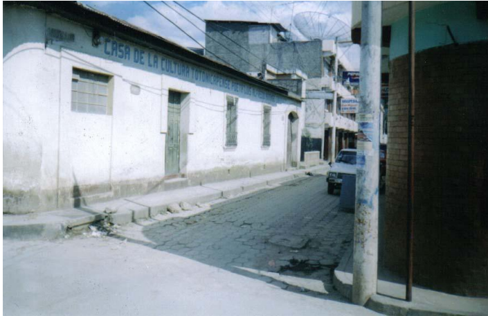
Foto I: Fachada sur, se observa el deterioro en el acabado, la humedad que afecta las paredes y la puerta de madera, la cubierta muestra Irregularidades y deterioro, rotulo agregado a la fachada.
