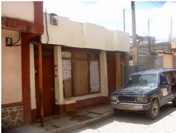
FOTO 9. Fachada sobre 8va Calle, contrasta con la arquitectura de la Casa de la Cultura.
