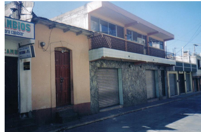
Foto 20,21 , edificio de dos niveles que contrasta con la pequeña entrada de otra vivienda que conserva algunas características de arquitectura antigua.
