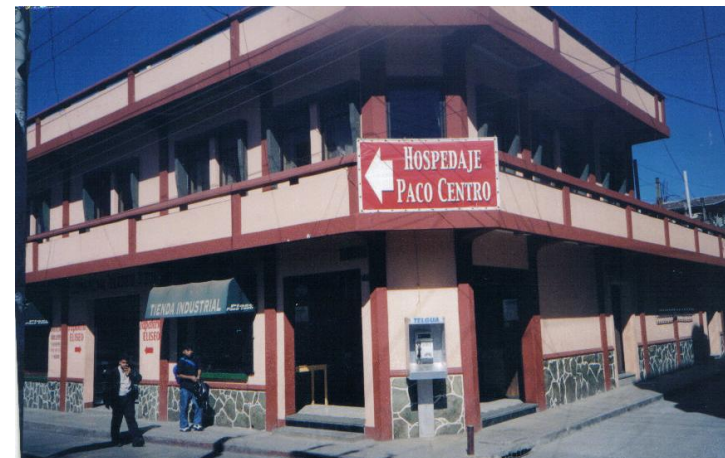
Foto 8 , edificio contrastante en color y materiales.
