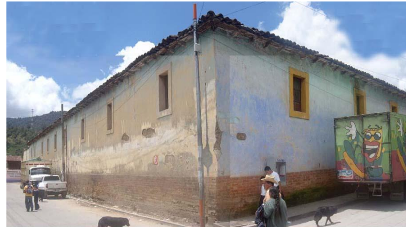
FOTO 27. Vista del Salón Municipal, edificio de gran valor cultural, en franco deterioro. Existe contaminación ya que los pobladores lo usan para realizar sus necesidades fisiológicas y como basurero.
