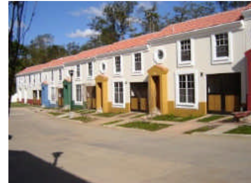
Fotografía 26. Casas con zaguán, repetición de módulos de vanos de ventanas y puertas.
