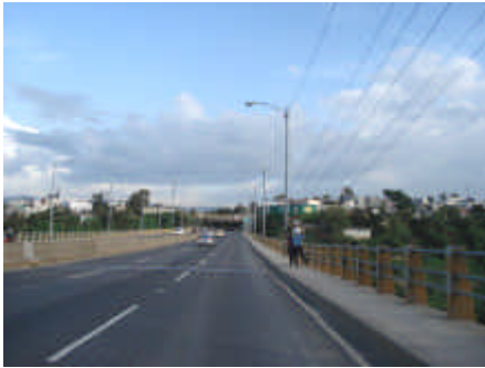
Fotografía 13. Puente El Naranjo.
