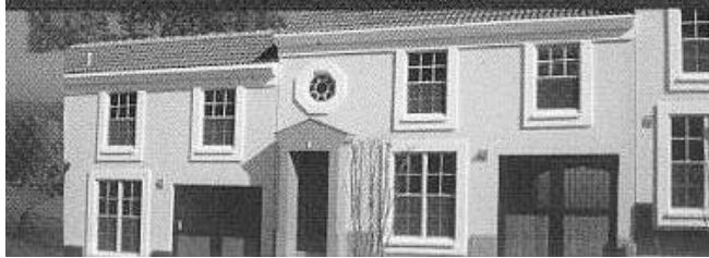
Fotografía 21. Construcción en serie de concreto reforzado
