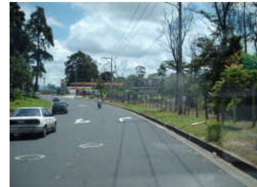
Fotografía 17. Uno de los carriles del Bulevar El Naranjo.
