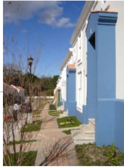
Fotografía 23. Se aprecia franjas de área verde, acera y jerarquía en los ingresos a las viviendas.
