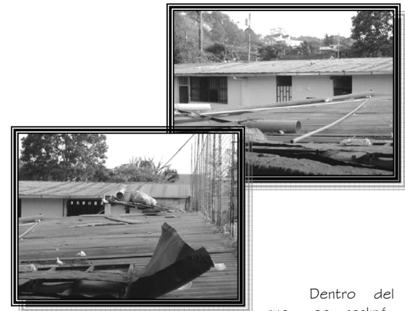
Dentro del estudio que se realizó se pudo constatar que el techo del Instituto se encuentra deteriorado, ya que en época de invierno se pueden detectar filtraciones; además, la estructura se encuentra picada y hay posibilidad de que en un momento dado se puede derrumbar.<sup>18</sup>
