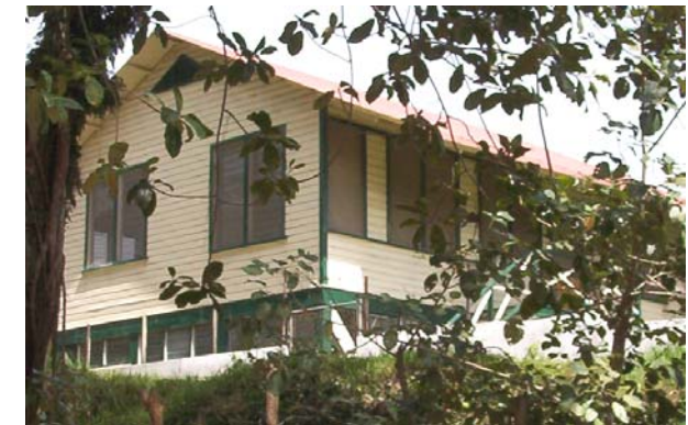
Fotografía No. 29. Edificio administrativo, poblado Playitas. Fuente: trabajo de campo.
