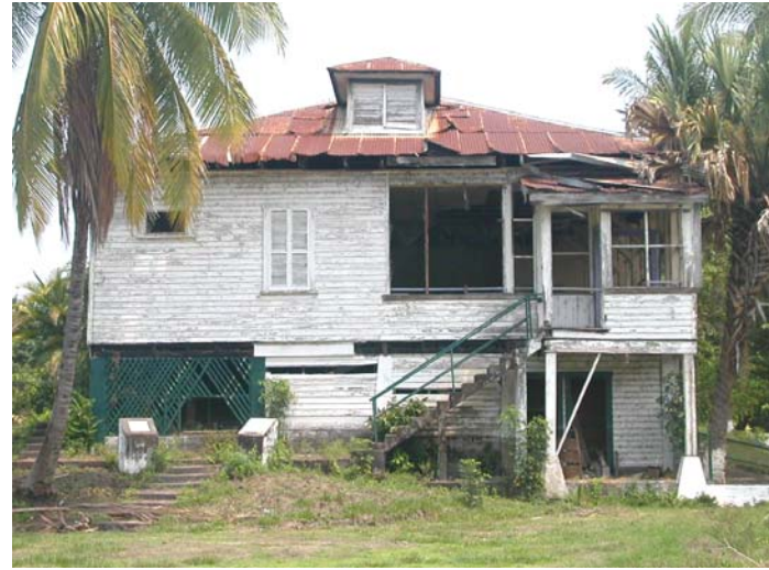
Fotografía No. 59. Hotel Itzamnia, Colonia El Prado, Tiquisate, Escuintla. Fuente: visita de campo.
