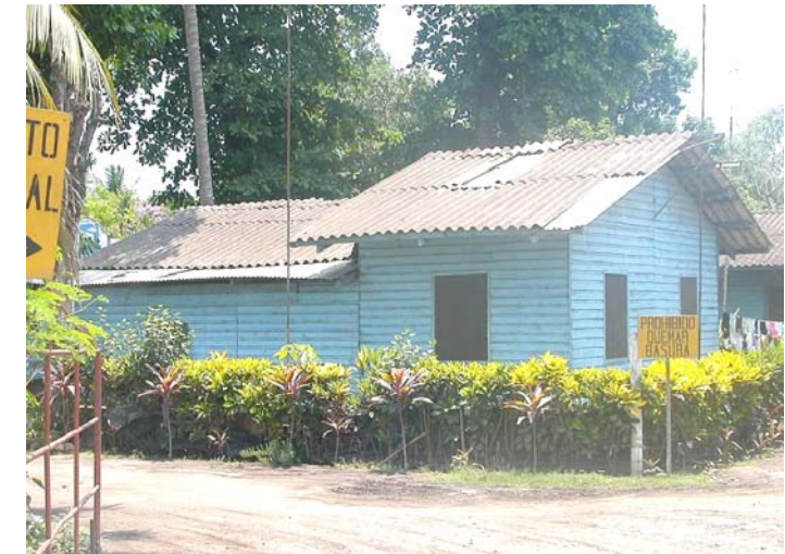
Fotografía No. 52. Vivienda Unifamiliar, llamada tipo "T", Finca La Ceiba, Tiquisate, Escuintla, Fuente: visita de campo.
