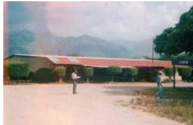
Fotografía No. 61. Planta empacadora, finca arapahoe Nuevo, distrito de Bobos, Morales, Izabal. Fuente: visita de campo.
