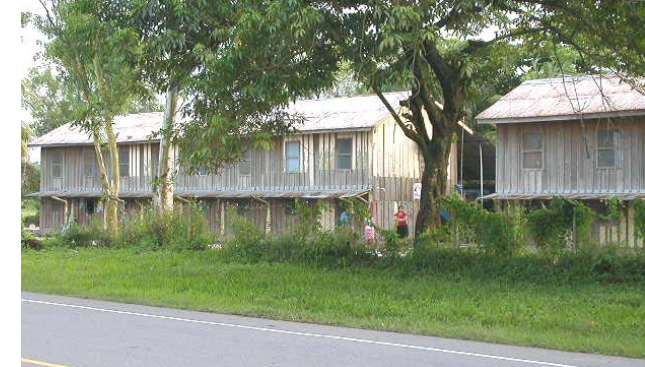
Fotografía NO. 34. En las fincas aún existentes se puede observar inmuebles tipo Yargas. Fuente: visita de campo.
