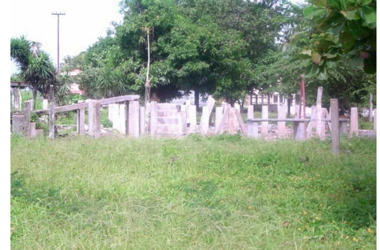
Fotografía No. 43. Vista de lo que queda del comisariato, finca Lankin, distrito de Bobos, Morales, Izabal. Fuente: trabajo de campo.
