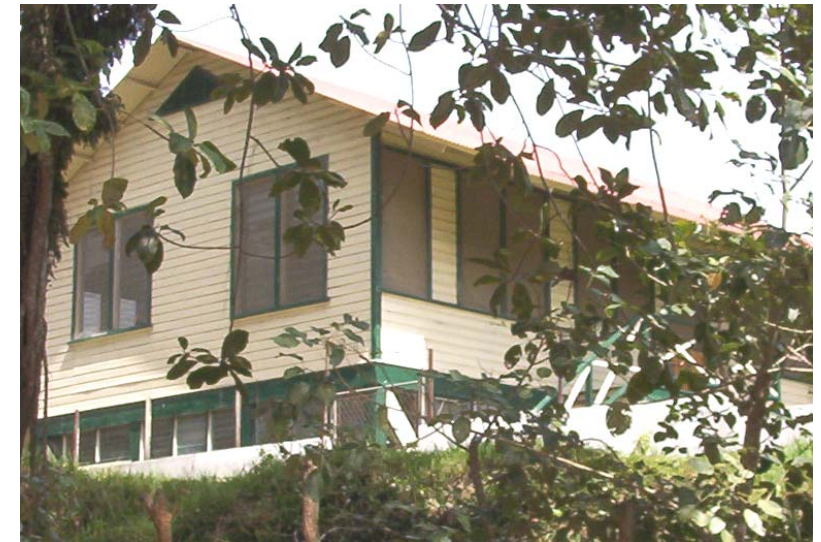
Fotografía No. 45. Edificio Administrativo en la finca Playitas, Morales, Izabal. Fuente: visita de campo.
