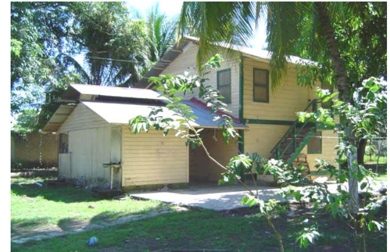
Fotografía No. 55. Vivienda bifamiliar, denominada modelo 2F-2RLC, finca Chicasaw, distrito de Motagua, Los Amates Izabal. Fuente: visita de campo.
