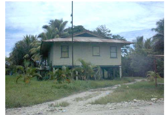
Fotografía No. 50. Vivienda Unifamiliar, finca Choctaw distrito del Motagua, Los Amates, Izabal Fuente: visita de campo.
