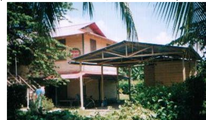
Fotografía No. 41. Vista frontal de Dispensario, finca Arapahoe Nuevo, distrito de Bobos, Morales, Izabal. Fuente: trabajo de campo.
