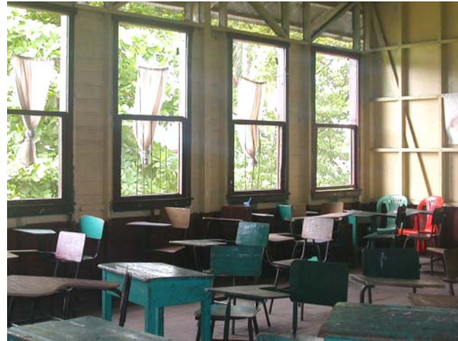
Fotografía No. 46. Aula del colegio Fray Bartoleme De Las Casas, área urbana de Tiquisate, Escuintla. Fuente: visita de campo.
