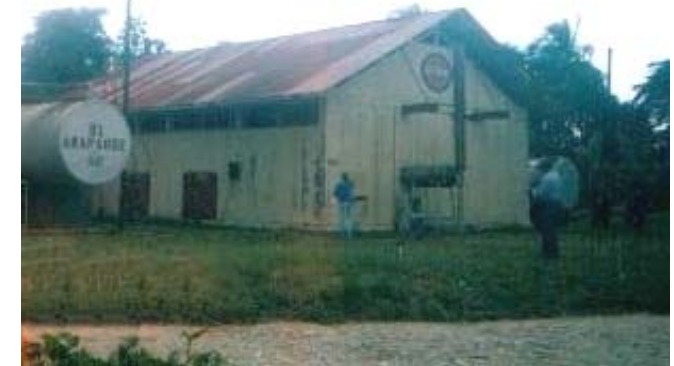
Fotografía No. 63. Bodegas y tanques de combustible, finca Arapahoe Nuevo, distrito de Bobos, Morales Izabal Fuente: visita de campo.
