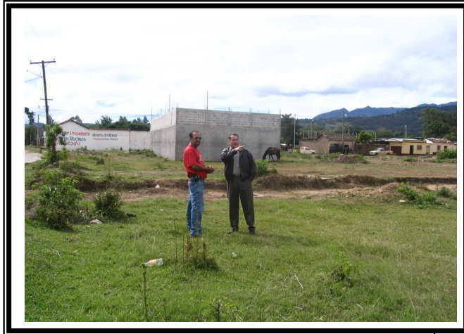
Fotografía No. 11 Construcciones existentes en Lotificación Los Mangos.
