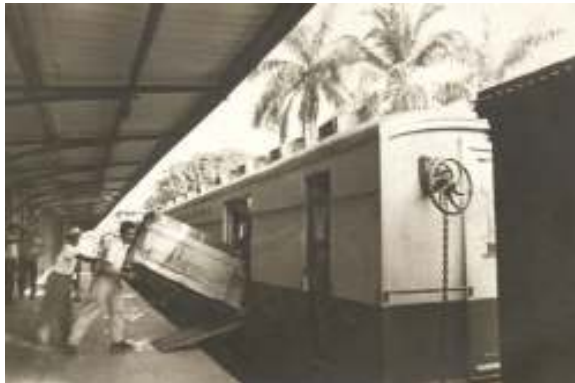
Foto No8 Adén de Carga de la Estación Puerto Barrios. Fuente: Carlos Torres.
