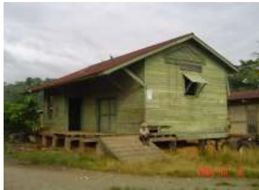
Foto No. 25. Estación de agencia de Cayuga, Izabal, en la actualidad. Fuente: Elaboración Propia.
