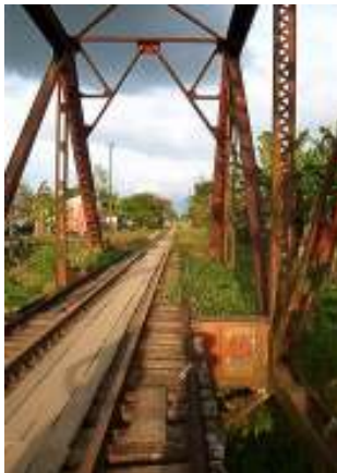
Foto No 23. Vista en Perspectiva de Puente de Tenedores. Fuente: Elaboración Propia.
