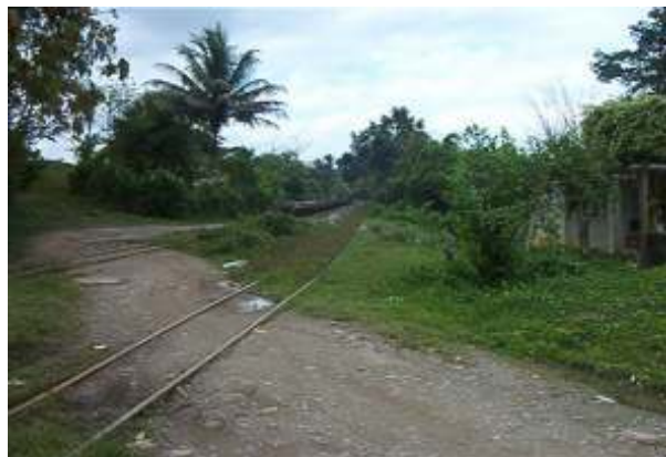
Foto No. 18. Tramo ferroviario de Castañeda, se observa muy tenuemente la línea férrea, ya no existen durmientes en la mayoría del tramo. Fuente: Elaboración Propia.
