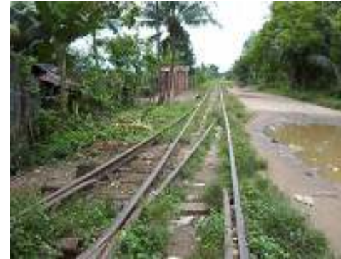
Foto No 15. Tramo ferroviario de Entre Ríos, Vista de un Switch, cercano a la estación.
