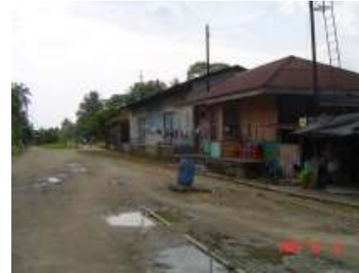
Foto No. 12. Perspectiva de la estación de Entre Ríos, vista nor.-este.
