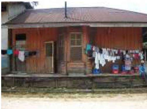
Foto No. 11. Vista Frontal de la Estación de Agencia de Entre Ríos. (Ver Análisis fotográfico del tramo en plano hoja No 90).
