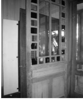
Puerta de ingreso a la sala. ( M. Alonzo).
