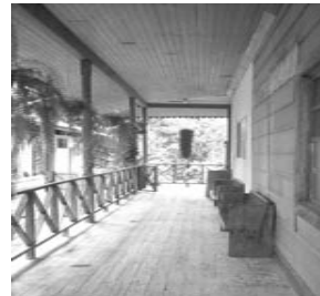
Vista de paredes exteriores del baño y dormitorio. (M. Alonzo).
