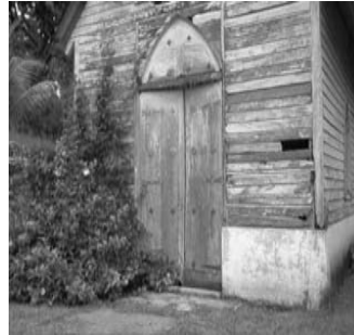
Detalle de la Puerta principal. (M. Alonzo).
