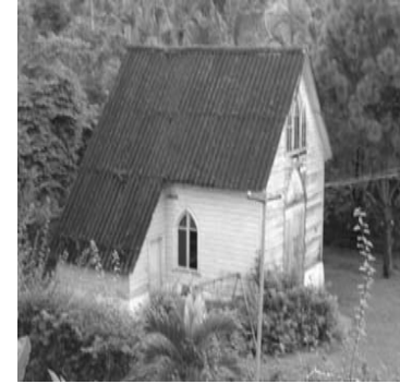
Vista lateral del techo iglesia (M. Alonzo).
