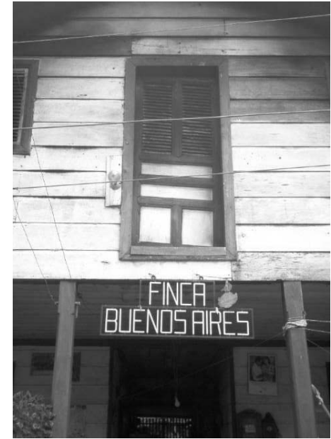
Detalle de ventanería exterior. (M. Alonzo).
