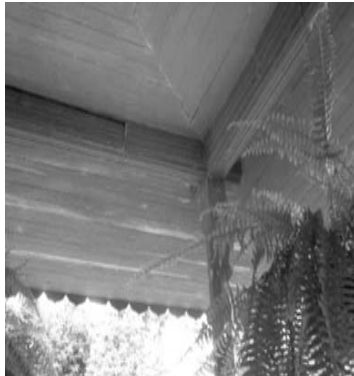
Detalle de la Crestería (M. Alonzo).
