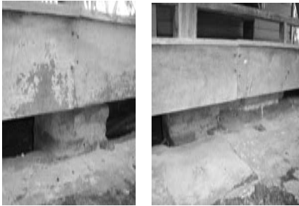
Vista de cimentación. (M. Alonzo).
