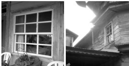
Detalle de ventanería exterior. (M. Alonzo).
