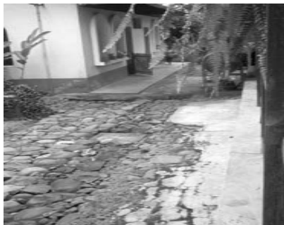
Detalle del piso y entrada a Cocina. (M. Alonzo).
