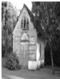
Fachada frontal de la Iglesia Católica RNP Buenos Aires. Foto: (F. Guzmán)
