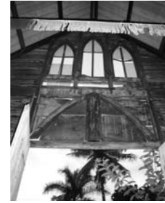
Detalle de puerta y ventanería principal . (M. Alonzo).
