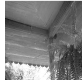
Vista de detalles techo. (M. Alonzo).
