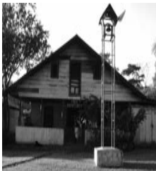
Fachada Frontal Casa del Administrador RNP Buenos Aires. Foto: (F. Guzmán)
