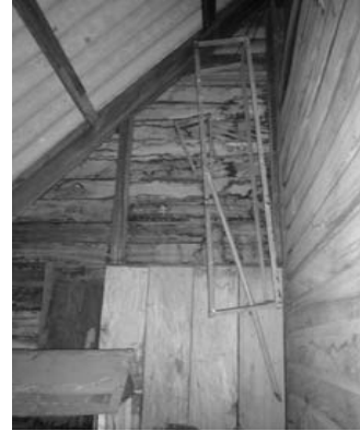
Vista interior sacristía. (M. Alonzo).
