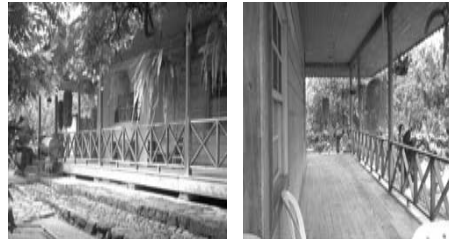
Detalle de las galerías de casa patronal. (M. Alonzo).
