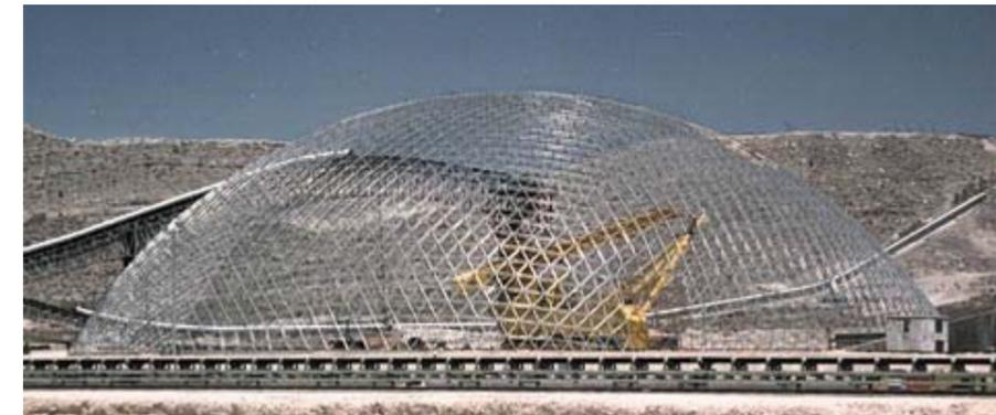
La tecnología Freedom permite cubrir tramos de hasta 300 metros sobre áreas de cualquier forma: circular, rectangular, poligonal o de forma libre. Un Freedom puede erigirse directamente sobre el terreno o puede descansar sobre columnas o muros de retención; el borde de soporte puede variar en elevación, curvatura y continuidad.
