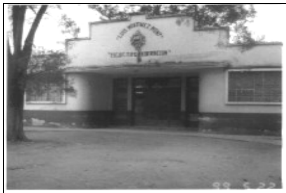
1 Se puede observar el escudo de armas que se encuentra en el frontispicio de la fachada de la escuela de Jalapa.
