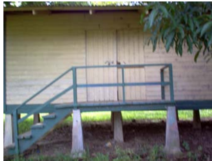
FOTO 15. ESTRUCTURA DE MODULO DE GRADAS
