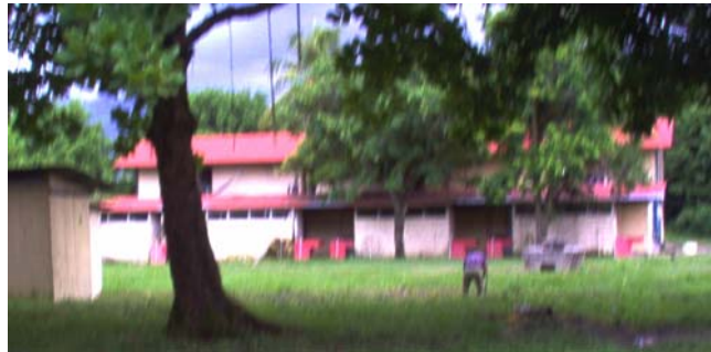
FOTO 30. VISTA DE LA FACHADA DE LOS SERVICIOS SANITARIOS.
