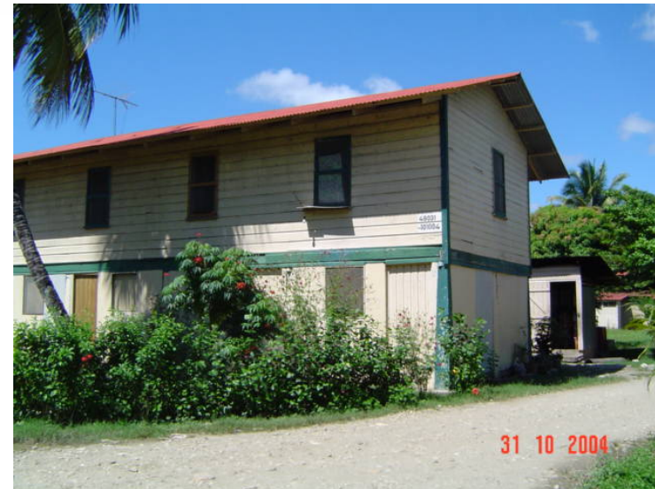
FOTO 29. FACHADA CON VISTA A ACCESO DE TERRACERÍA.
