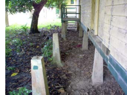
FOTO 13. TIPO DE CIMENTACIÓN AISLADA EN GRADAS
