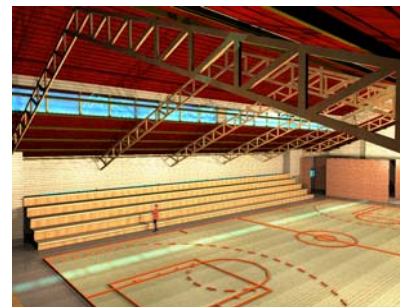
26. VISTA DE ARMADURA JOIST DE MADERA
