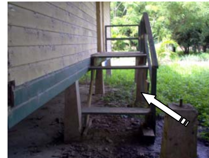
FOTO 22. MÓDULO ESTRUCTURAL DE GRADAS.
