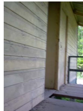
FOTO 14. VISTA DEL ENTABLONADO DE LOS MUROS
