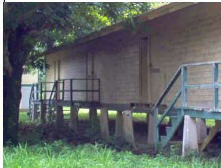
FOTO 12. TIPO DE CIMENTACIÓN AISLADA
