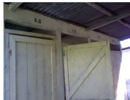
FOTO 18 DETALLE DE PUERTAS DE SERVICIOS SANITARIOS
