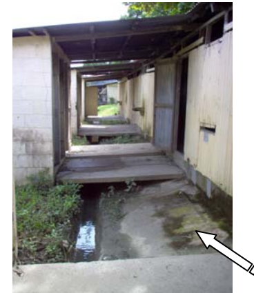
FOTO 25. INGRESO A SERVICIOS SANITARIOS Y COCINA.
