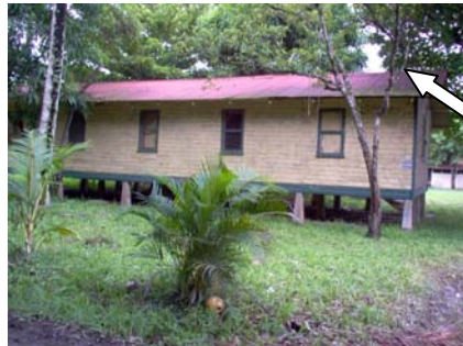
FOTO 24. VISTA DEL MATERIAL DE LA CUBIERTA.
