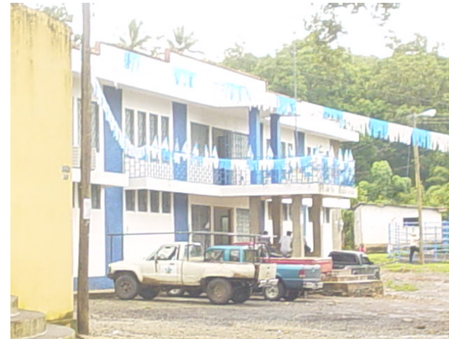
Municipalidad de Guanagazapa. Edificio de dos niveles. Fuente: elaboración propia. Marzo 2005.
