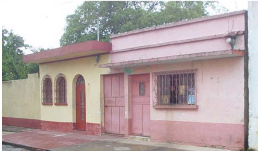
Viviendas urbanas integradas, de mampostería y losas de concreto (la izquierda). Se aprecia un sistema constructivo reciente. Fuente: Elaboración propia. Marzo 2005
