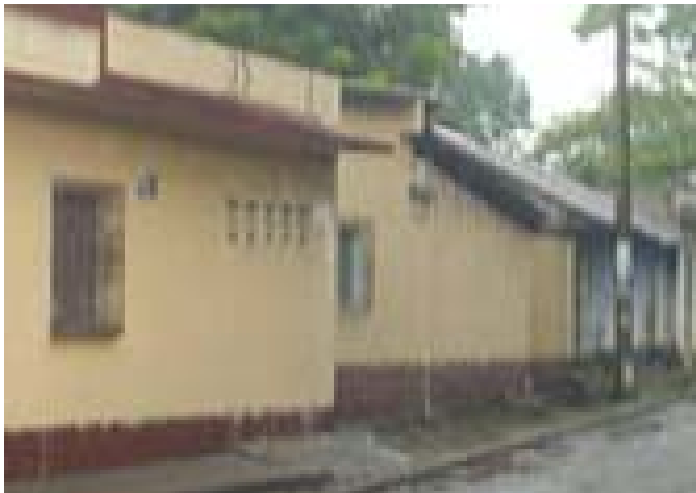
Vivienda de muros de mampostería con lámina de zinc. Fuente: Elaboración propia. Marzo 2005.
