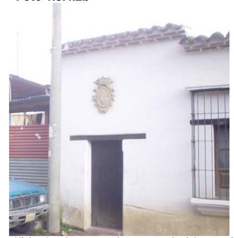
Vivienda urbana con elementos coloniales sencillos, de un estrato social medio. Este tipo de vivienda se observó con más regularidad en los márgenes del casco urbano. Elaboración propia. Marzo 2005.
