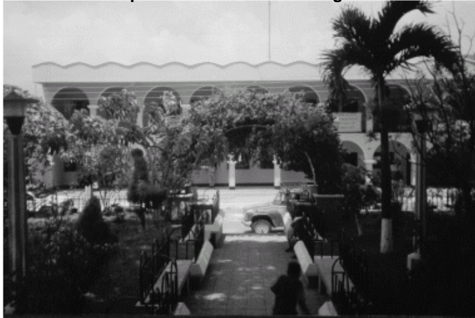
Foto 2.2.2.6c Arquitectura de Chimaltenango
