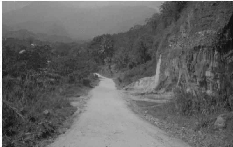
Carretera de ingreso al municipio de Pochuta (vía Patulul); ancho promedio de 5.50m, transitable en época seca del año y de difícil tránsito en invierno. Fuente: Elaboración Propia. Marzo 2005.
