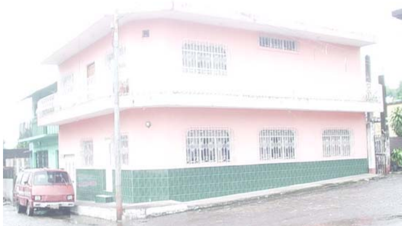
Viviendas de mampostería con losas de concreto armado de dos niveles. Evidencian ser de un mejor estrato económico. Fuente: Elaboración propia. Marzo 2005.
