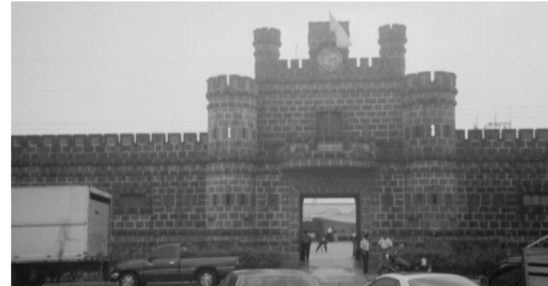
Fachada frontal del palacio de la Policía Nacional. Define una arquitectura de siglos atrás. Fuente: Elaboración Propia. Marzo 2005.
