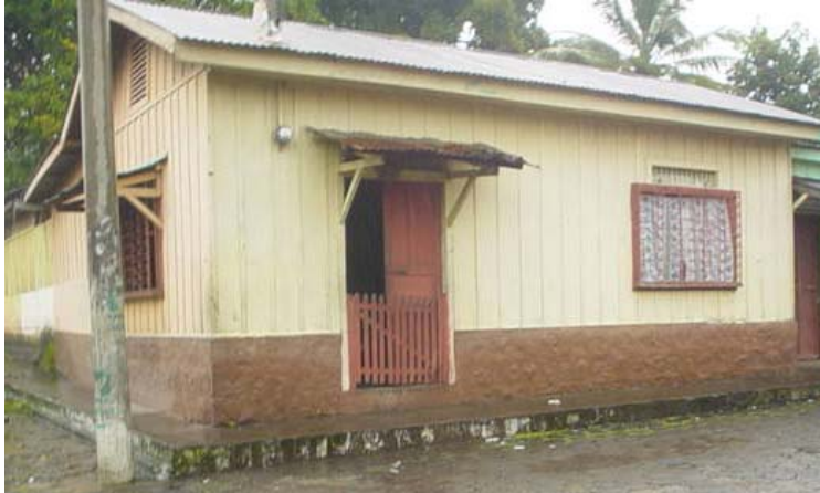
Vivienda con sistema mixto: mampostería más madera con techo de lámina de zinc y acabados de madera. Fuente: Elaboración propia. Marzo 2005.
