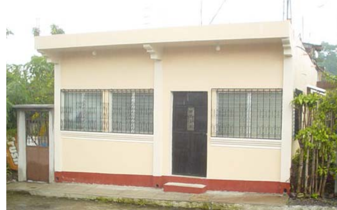
Vivienda de muros de mampostería y losa plana de concreto, más acabados. Fuente: Elaboración propia. Marzo 2005.
