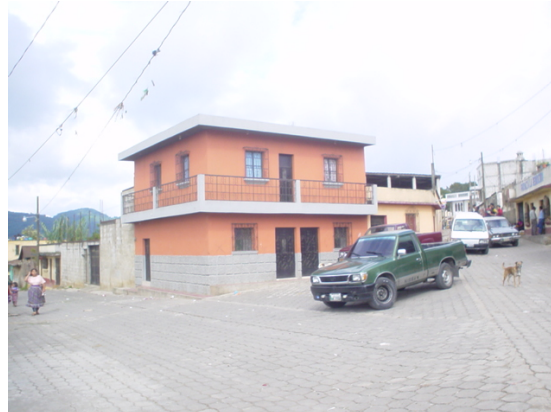
Vivienda de block repellada y cernida con losa de concreto, propia del segmento más desarrollado y minoritario. Fuente: Elaboración propia. Marzo 2005
