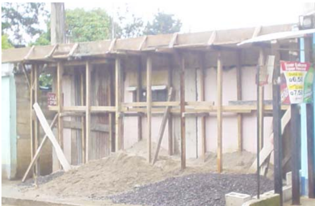
Sistema constructivo de block – mixto de un nivel Fuente: Elaboración propia. Marzo 2005
