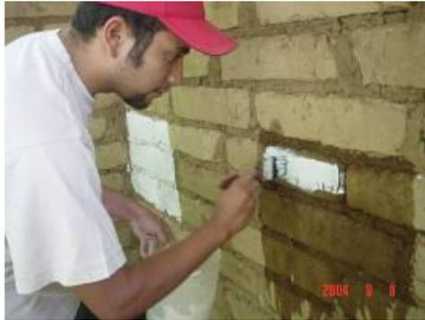
**Fotografía No. 53:** Aplicación de pinturas a base de cal y agua, encontrando las proporciones ideales
