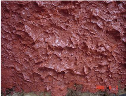
**Fotografía No. 17:** Colorante en la mezcla, además de utilización de una textura distinta elaborada con la
