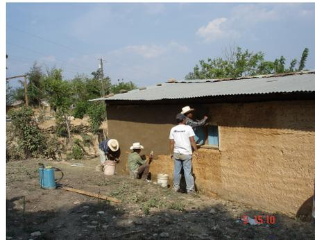
**Fotografía No. 29:** Aplicación del revestimiento por parte de los participantes con ayuda de instrumentos de albañilería
