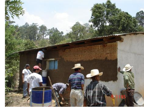
**Fotografía No. 27:** Aplicación del revestimiento por parte de los participantes
