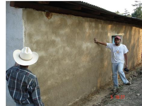
**Fotografía No. 30:** Revestimiento aplicado totalmente, ahora en proceso de secado.
