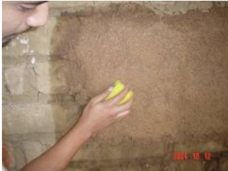
**Fotografía No. 62:** Luego de la aplicación del revestimiento se procede a realizar un alisado con esponja
