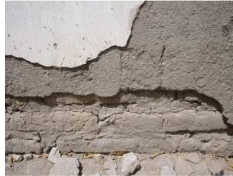
**Fotografía No. 9: DETERIORO EN LOS REVESTIMIENTOS:**
