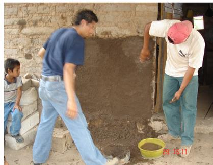
**Fotografía No. 68:** Alisado con la mano luego de la aplicación del revestimiento
