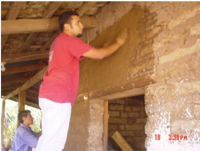
**Fotografía No. 22:** Demostración de la forma de aplicar el revestimiento
