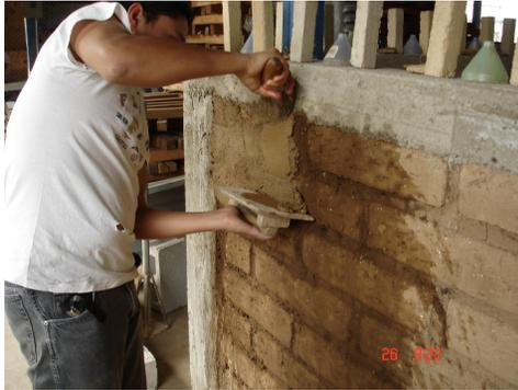
**Fotografía No. 60:** Aplicación del revestimiento con instrumentos de albañilería
