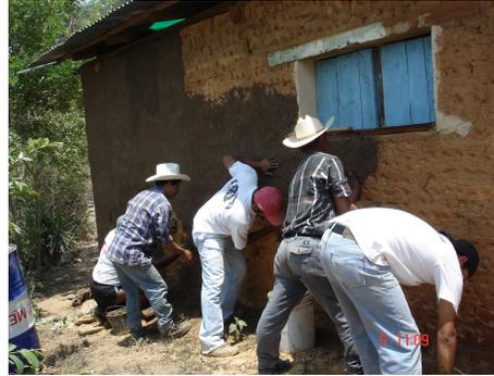
**Fotografía No. 26:** Aplicación del revestimiento de forma manual
