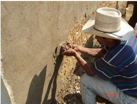
**Fotografía No. 28:** Aplicación del revestimiento con ayuda de instrumentos de albañilería
