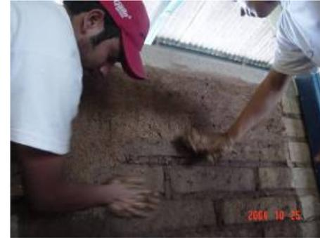
**Fotografía No. 61:** Aplicación manual del revestimiento
