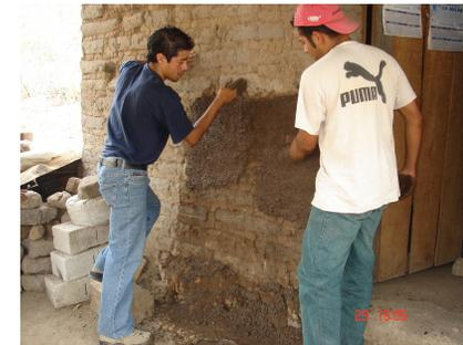
**Fotografía No. 66:** Aplicación manual de arriba hacia abajo
