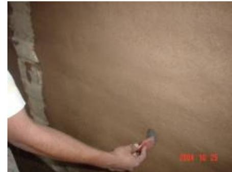
**Fotografía No. 63:** Después del alisado y ya secado el revestimiento, se pasa una escoba o brocha para eliminar los granos que quedan sueltos luego del alisado
