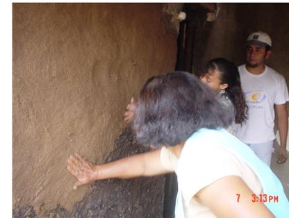
**Fotografía No. 24:** Interactuando con los participantes en la aplicación del revestimiento
