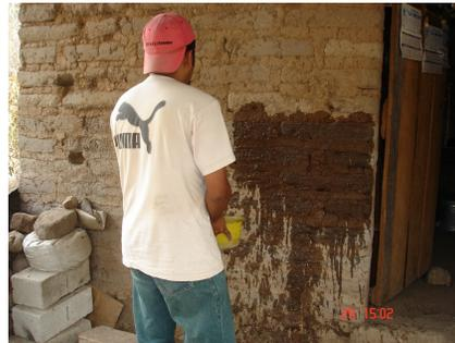
**Fotografía No. 65:** Saturación de agua previo a la aplicación
