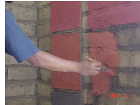
**Fotografía No. 18:** Aplicación de distintos colores sobre revestimientos y sobre los mampuestos de adobe
