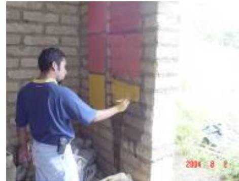
**Fotografía No. 54:** Aplicación de pinturas a base de cal y agua, añadiéndoles colorantes
