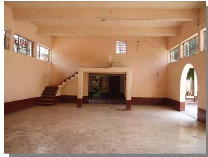
VISTA INTERIOR Edificio Existente
