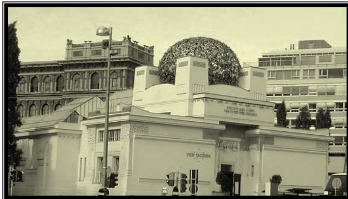
Edificio de Exposiciones de la Secesión
