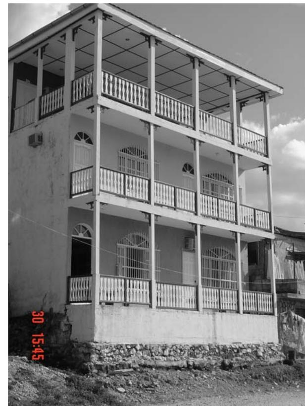
Fotografía 002 / Se observa en la fotografía el corte en la alineación de la fachada.
