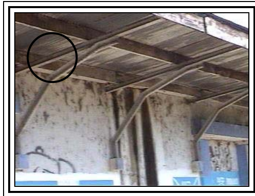
FOTOGRAFÍA No. 62. (Techos).
