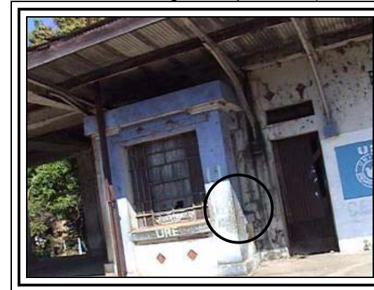
FOTOGRAFÍA No. 56. (Paredes).
