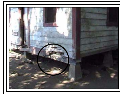
FOTOGRAFÍA No. 76. (Vigas de madera).
