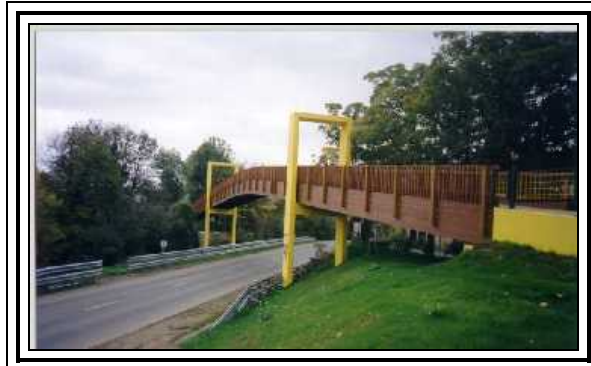
FOTOGRAFÍA No. 4. Pasarela sobre carretera en Estibaliz, Vitoria, España.
