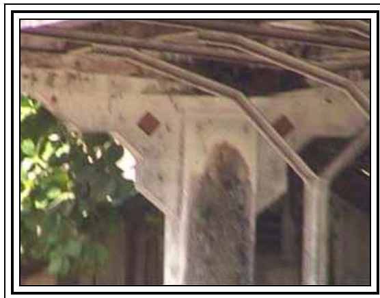
FOTOGRAFÍA No. 67. (Estructura).
