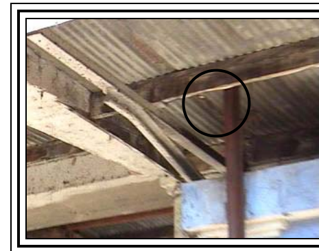
FOTOGRAFÍA No. 60. (Estructura).
