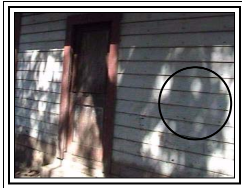
FOTOGRAFÍA No. 77. (Puertas).
