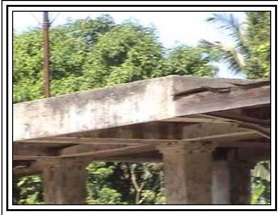
FOTOGRAFÍA No. 70. (Andén concreto).
