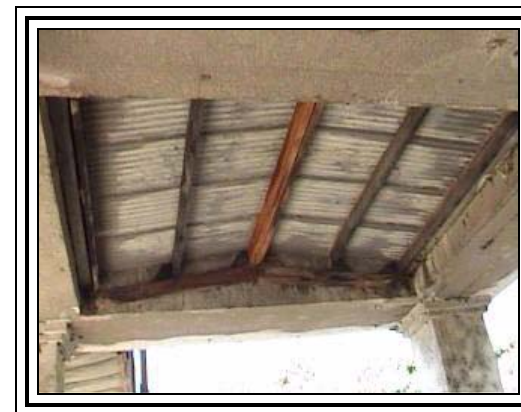
FOTOGRAFÍA No. 69. (Techo andén concreto + lámina).
