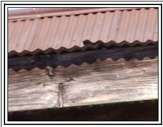
FOTOGRAFÍA No. 71. (Viga andén metálico).
