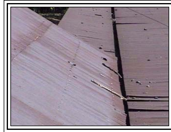
FOTOGRAFÍA No. 72. (Techo andén metálico).
