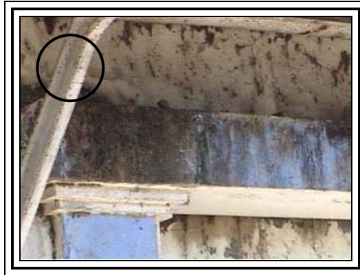
FOTOGRAFÍA No.61. (Vigas).
