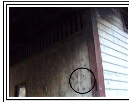
FOTOGRAFÍA No. 75. (Paredes).
