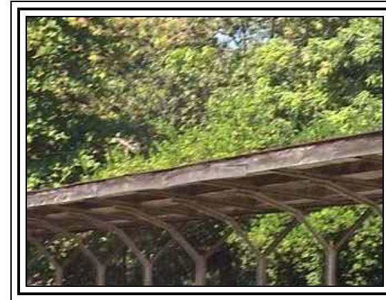
FOTOGRAFÍA No. 68. (Andén metálico).
