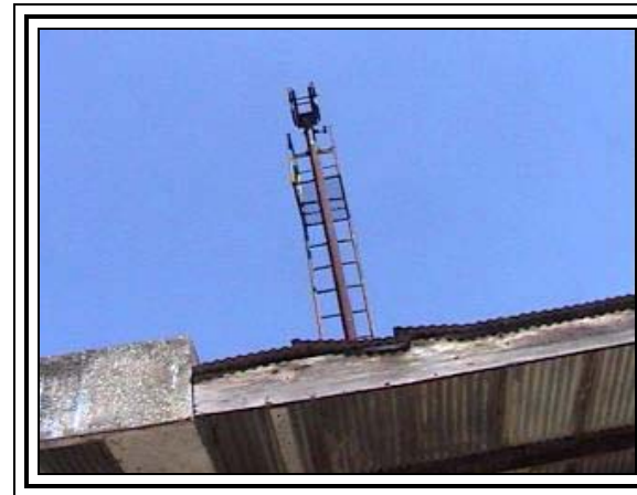
FOTOGRAFÍA No. 73. (Torre en andén).
