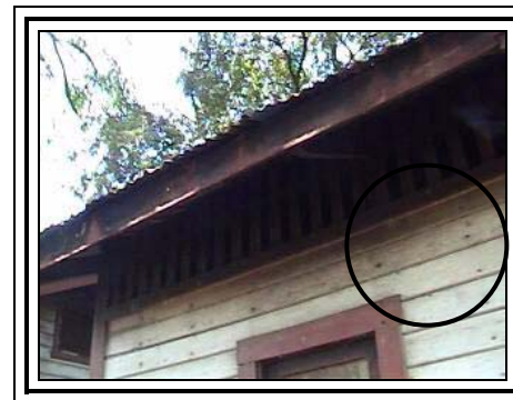
FOTOGRAFÍA No. 80. (Voladizo).
