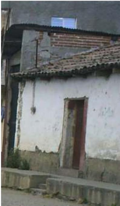
Con el transcurso del tiempo estas mismas construcciones han cambiado, para los cimientos ciclópeos no se utiliza lodo sino que cemento y los muros se refuerzan con acero además de cubiertas con lamina de zinc.
