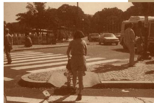
IMAGEN 1.6-1: SISTEMA DE RAMPAS EMPLEADO EN CURITIBA- BRASIL “La arquitectura debe ser empleada como un elemento de “inserción social” que permita el uso de los espacios sin ningún tipo de restricción.”
