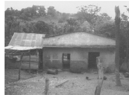
FACHADA FRONTAL INGRESO PEATONAL Y SALIDA DE CANALES
