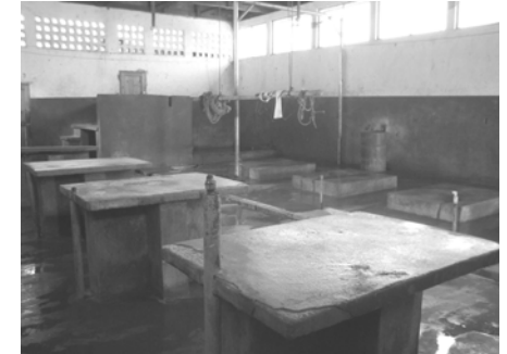
INTERIOR DEL RASTRO ÁREA DE FAENADO BOVINOS Y PORCINOS
