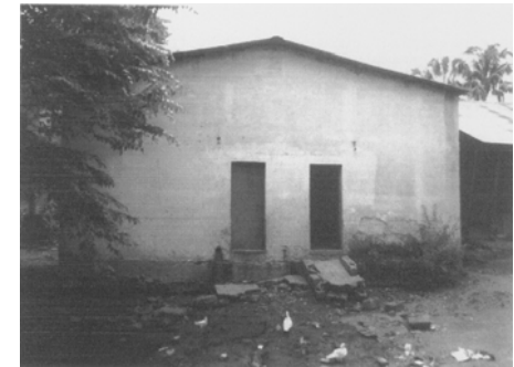
FACHADA POSTERIOR ÁREA DE DEPÓSITO DE DESECHOS
