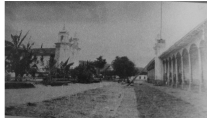
Foto No 101 Elevación lateral del edificio Municipal norte a sur. Fotografía digital tomada de los pasillos de Gobernación departamental. 2005
