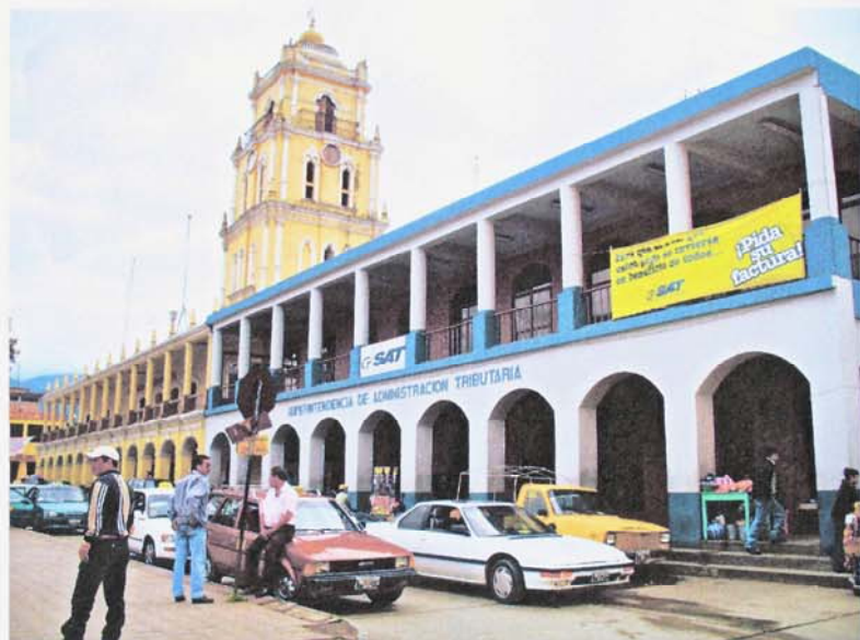
Edificio de Gobernación
