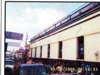
Foto No 29 Elevación lateral del edificio.
