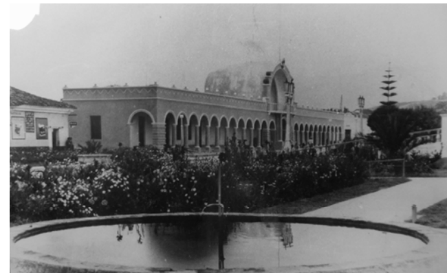
Foto No 102 Elevación lateral del edificio Municipal sur a norte. Fotografía digital tomada de los pasillos de Gobernación departamental. 2005
