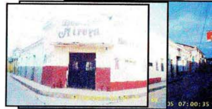
Elevación Principal del Inmueble Fotos No 30-31-32
