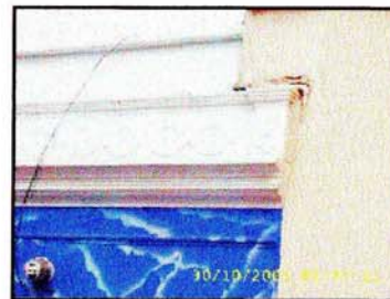
Elevación de la cornisa Foto No 68
