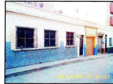
Elevación principal del inmueble Foto No 61
