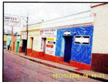
Elevación Principal del Inmueble Foto No 67
