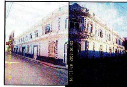
Elevación en esquina del inmueble Foto No 43-44
