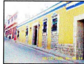
Elevación Principal del Inmueble Foto No 65
