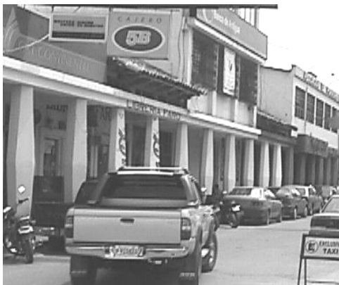
Foto No 120 Fachada Principal Locales comerciales al norte
