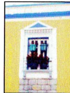
Elevación del detalle de las ventanas Foto No 66
