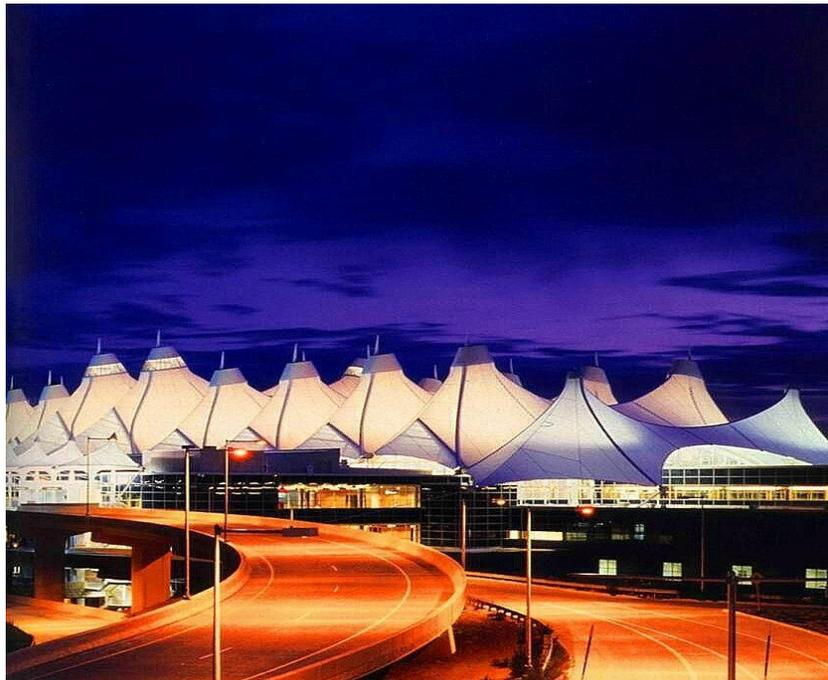
El edificio se basa en su sección transversal con bloques de aparcamiento de lado a lado y crecen conforme se aproximan al vestíbulo central coronado con la cubierta, se trata de estructuras de crujeas simétricas que se repiten de manera idéntica a lo largo de su eje perpendicular.
