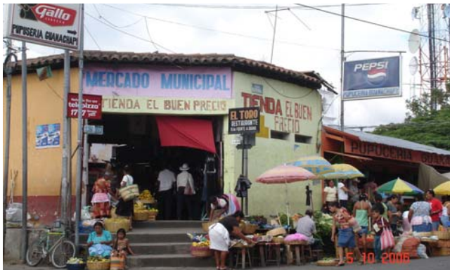
Fotografía No.3 Ingreso principal a Mercado Central
