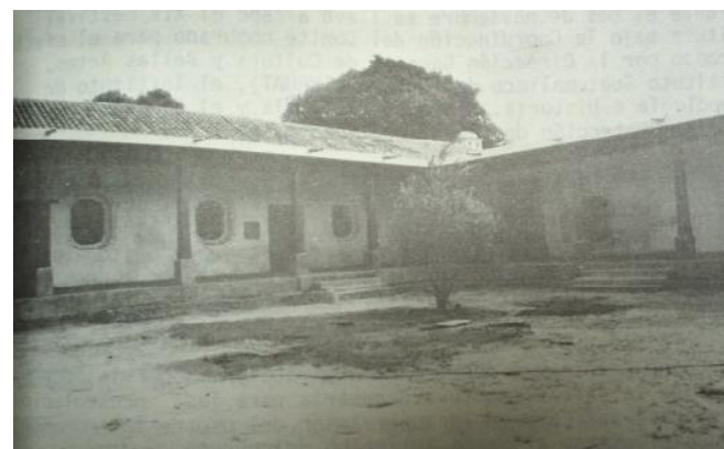
Fotografía 19. Vista del edificio ya restaurado. 144
