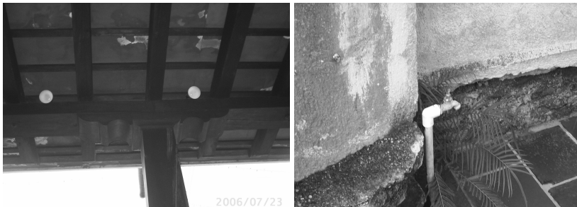
Fotografías no. 72 y 73. Se observa el capitel de las columnas y las vigas utilizadas en la cubierta. Se observa también un sobrecimiento de piedra.
