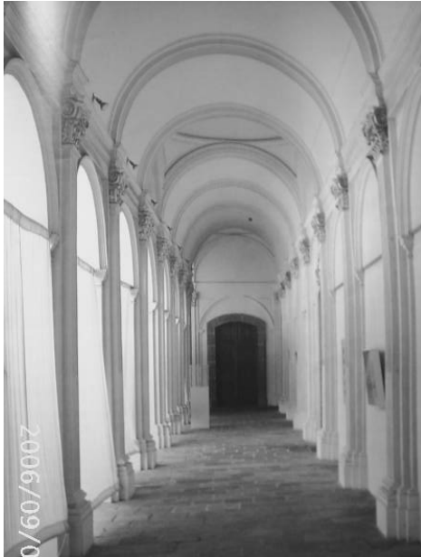
Gráfica 11: detalle de un corredor. Al lado izquierdo se encuentran los ingresos a los salones al lado derecho se encuentra el patio interior.
