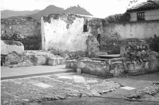
Fotografía 50. Vista desde el segundo patio de las edificaciones en ruinas, observando al fondo las habitaciones del Hotel Casa Santo Domingo.
