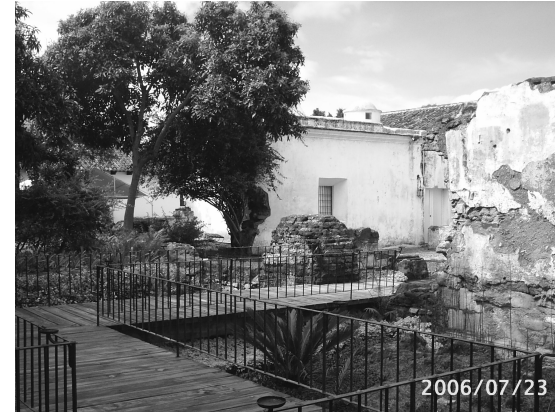
Fotografía 60. Detalle del puente ubicado en el Colegio Santo Tomás que se une con el Hotel Casa Santo Domingo.
