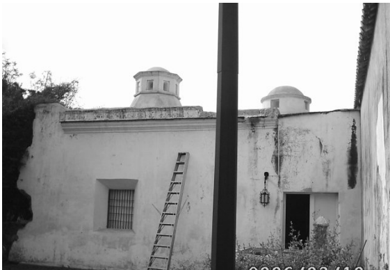
Fotografía 51. Área restaurada donde se encuentra la cocina, se observan las chimeneas que rematan las cúpulas. Así como los frisos que rematan los muros. Este ambiente se encuentra junto al segundo patio.
