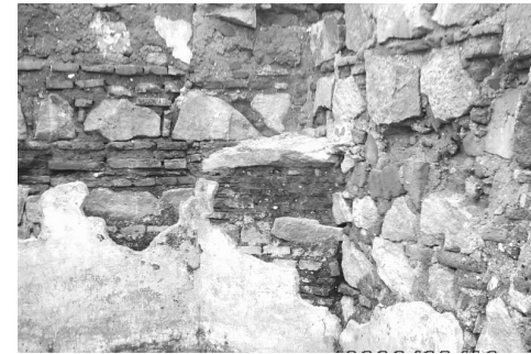
Fotografía 62. Detalle de conformación de muros, de calicanto con rafas de ladrillo de barro cocido.
