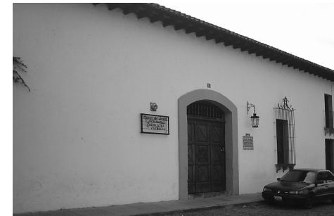
Fotografía 10. Se puede observar que la portada en la parte superior remata con un arco de medio punto rebajado, característica del estilo neoclásico, el cual fue utilizado en Guatemala a partir del siglo XVIII. Se cree que estos cambios se realizaron después del terremoto de 1917.
