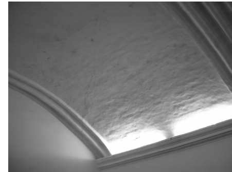
Fotografía 66. Detalle de la bóveda de cañón corrida del salón General Mayor.
