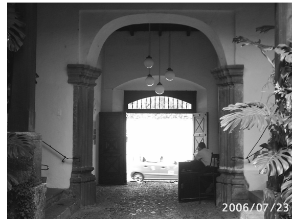
Fotografía 61. Vista desde el patio principal del arco de ingreso, con sus bases de piedra y el zaguán.
