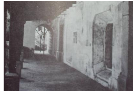
Fotografía 16. Fachada Salón General Mayor y corredor hacia segundo patio 139
