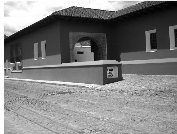
Fotografía 27: Ingreso al Parqueo del Hotel Casa Santo Domingo
