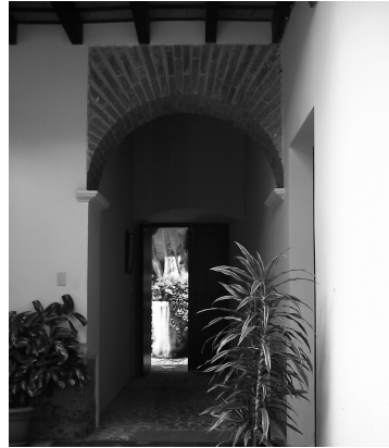
Fotografía 64. Detalle del arco elaborado con ladrillo de barro cocido, ubicado en el ingreso del albergue.
