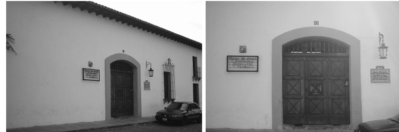
Fotografías no. 80 y 81. Se observan los elementos que forman parte de la fachada principal del Colegio Mayor Santo Tomás de Aquino.
