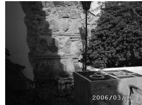
Fotografía 45. Detalle de pila dentro del albergue
