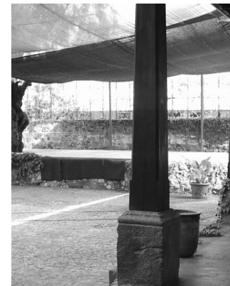
Fotografía 63. Se observa que las columnas están elaboradas en madera sobre una base de piedra.
