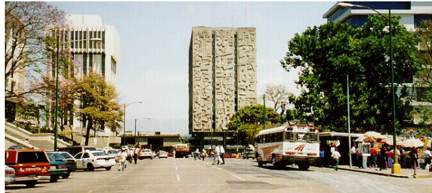
Relieves en las fachadas, con figuras que identifican a Guatemala. Edificios Municipales zona 4, Guatemala
