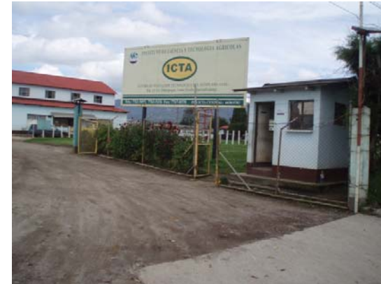
Fotografía No. 11 Ingreso Principal Fincas del ICTA polígono 1, Garita de ingreso y parqueo.
