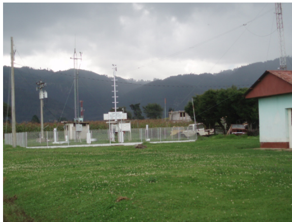
Fotografía No. 14 Área propiedad del INSIVUMEH, al fondo viviendas colindantes con el terreno.
