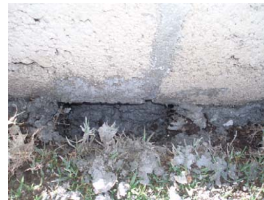
Muros de mampostería.
