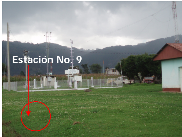
Fotografía No. 26.1 Módulo oficina tecnología, estación No. 8 -9.
