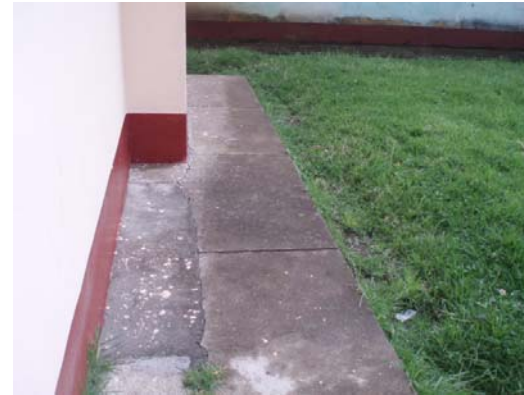
Alrededor de todos los módulos se observa una banqueta de concreto con un espesor de 0.10 mts., y un ancho de 0.80 mts.
