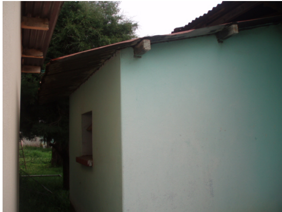
Módulos con techos en aguas, estructura de madera + lamina.
