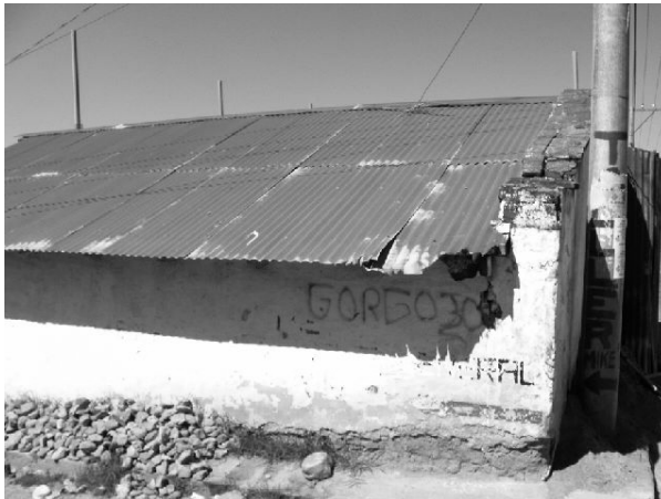
FOTO No. 34. TECHOS DE LÁMINA
