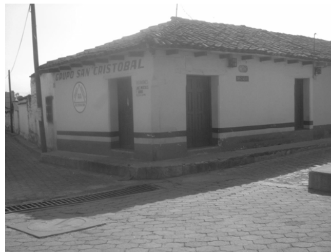
FOTO No. 59. TECHO DE TEJA
