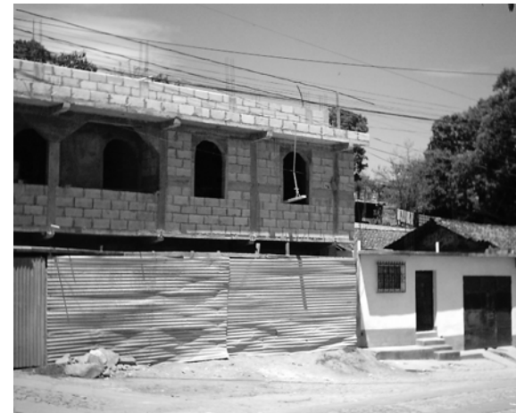
FOTO No. 74. MUROS DE BLOCK
