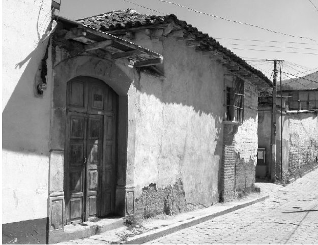
FOTO No. 27. MUROS DE ADOBE
