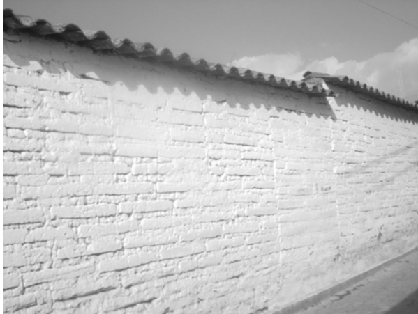
FOTO No. 31. MUROS DE ADOBE
