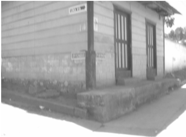
FOTO No. 28. MUROS DE BLOCK Y MADERA
