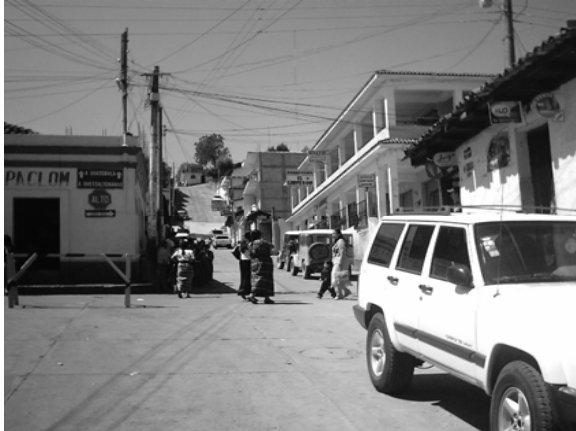
FOTO No. 66. CONTAMINACIÓN VISUAL POR CABLES
