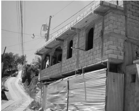
FOTO No. 76. MUROS DE BLOCK
