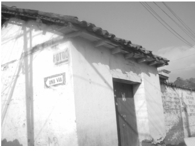
FOTO No. 58. TECHO DE TEJA
