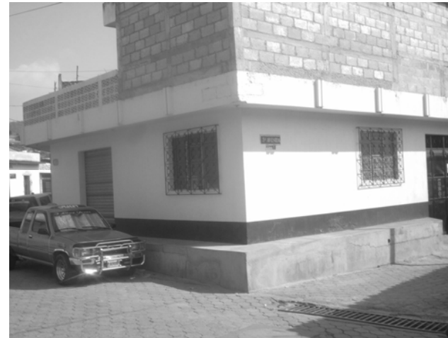
FOTO No. 30. MUROS DE BLOCK
