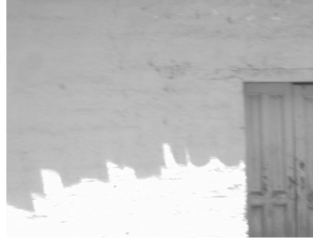
FOTO No. 29. MUROS DE ADOBE
