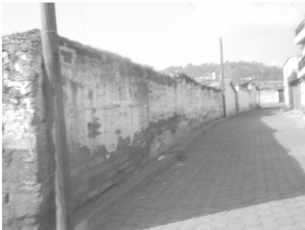
FOTO No. 32. MUROS DE ADOBE
