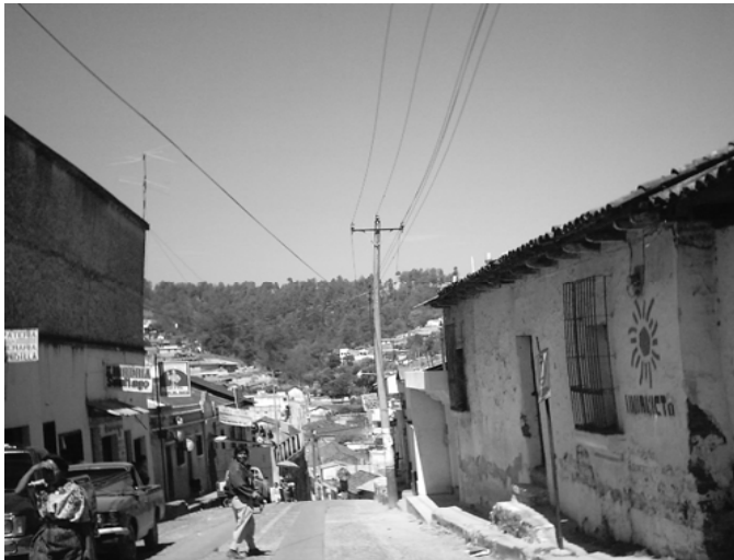
FOTO No. 67. CONTAMINACIÓN VISUAL POR CABLES
