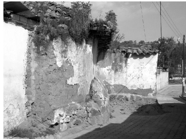
FOTO No. 53. MUROS DE ADOBE
