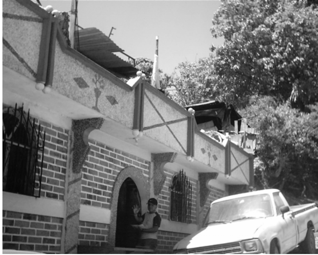
FOTO No. 75. MUROS DE LADRILLO
