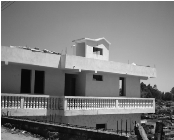
FOTO No. 79. TECHO DE LOSA FUNDIDA
