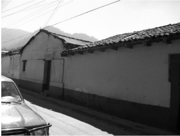
FOTO No. 33. TECHOS DE TEJA
