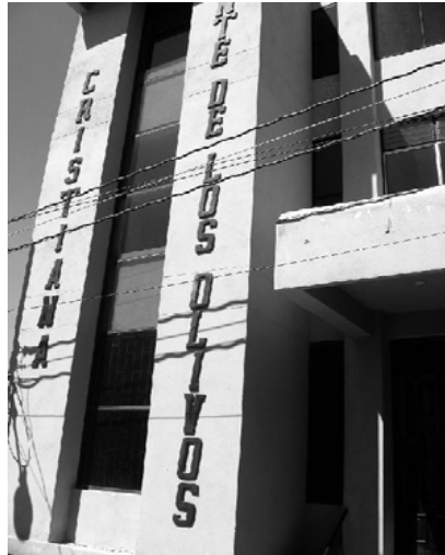
FOTO No. 16. CONTAMINACIÓN VISUAL POR CABLES
