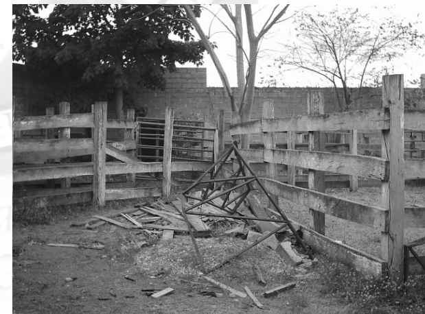
FOTO No. 16: VISTA INTERIOR DE CORRALES
