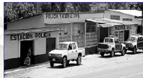
FOTO No. 9: EDIFICIO POLICÍA NACIONAL CIVIL
