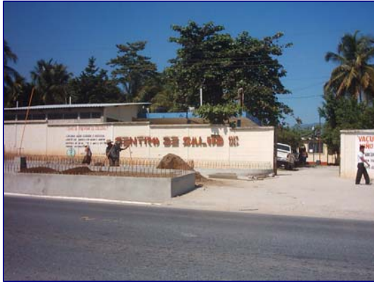
FOTO No. 2: VISTA INGRESO CENTRO DE SALUD
