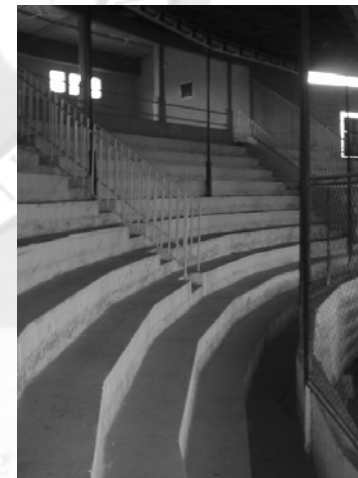
FOTO No. 18: VISTA INTERIOR, ÁREA DE GRADERÍO, COLISEO CHIQUIMULA
