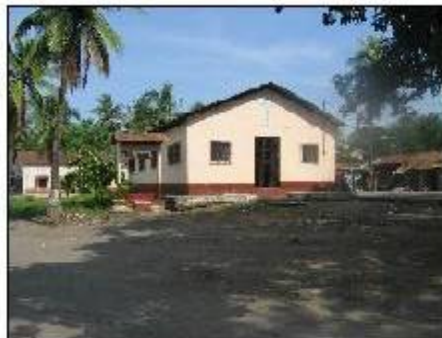
VISTA FRONTAL DE LA IGLESIA, Y PARTE DEL ENTORNO.
