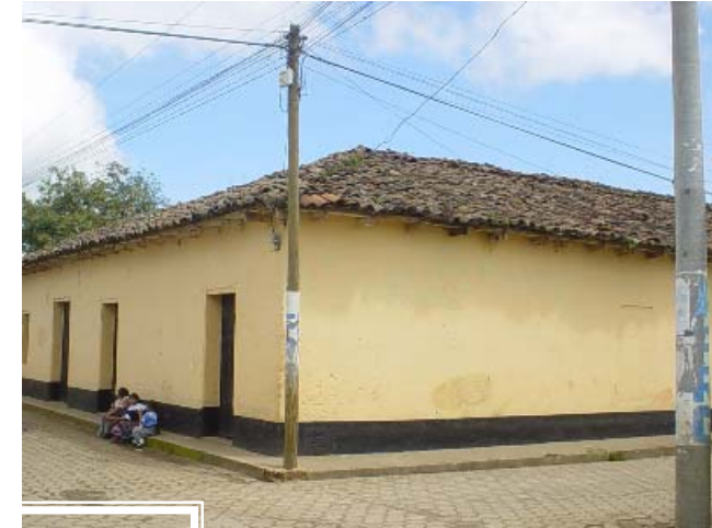
FOTO 25. El artesonado de madera para la estructura de la cubierta se observa en esta fotografía.
