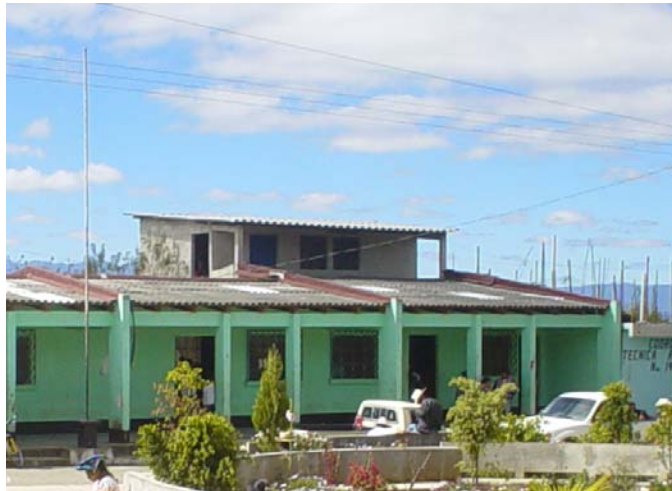
FOTO 27. AUTOR: IMAGEN PROPIA. 2,006 Las construcciones se entremezclan en edificaciones horizontales (1 nivel), y edificaciones verticales (2,3 hasta 4 niveles)
