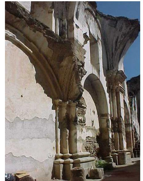
En el terremoto de 1773, fue el templo el que sufrió los mayores daños, con colapso total de la cubierta. El edificio fue construido, como era la costumbre en la época, con el sistema de calicanto, esto es, muros de piedra unidos con argamasa, con hiladas de ladrillo de barro cocido intercaladas con cierta frecuencia y utilizado en la construcción de arcos y bóvedas.
