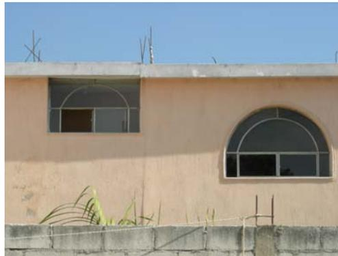
**Ilustración 92 Arco dentro de vano rectilíneo**
