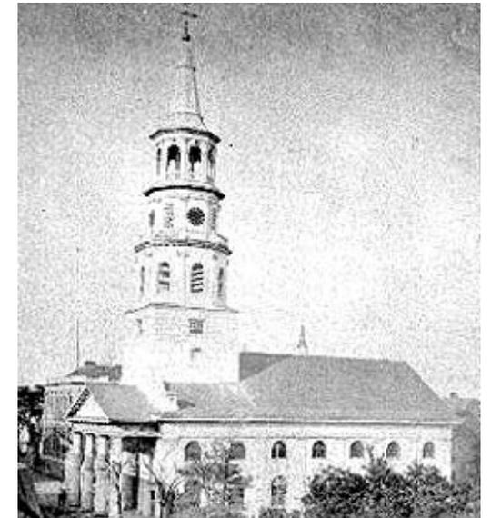
El pórtico es una reminiscencia del megarón, la cual, en este caso provee del estatus necesario al conjunto. La aparente inocencia del detalle esconde un principio utilizado con frecuencia, en el sentido de hacer trabajar las columnas bajo esfuerzos axiales, dejando la responsabilidad de los desplazamientos laterales a los muros de la nave principal.
