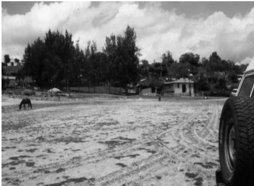
Foto No.1. Localización de cancha de fútbol en la aldea Santa cruz de San Jerónimo, la cual se encuentra en mal estado y con mucha deficiencias funcionales por falta de mantenimiento.
